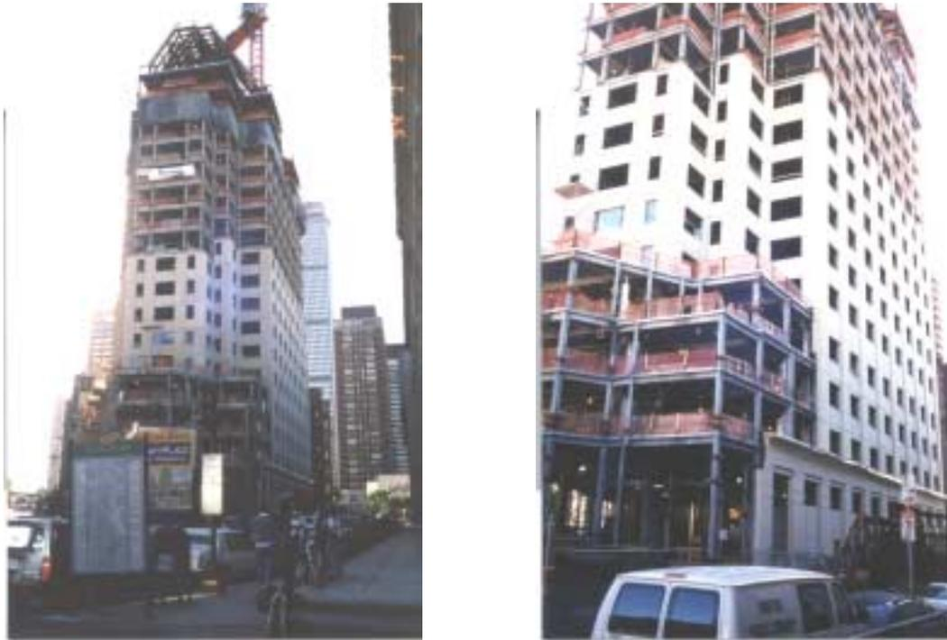
**Figura 1.1: Exemplo de uma edificação em estrutura metálica com vedação em painéis de concreto, Boston – EUA.**
