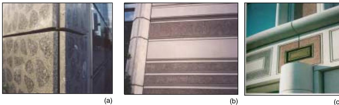
**Figura 3.4:** Exemplos de acabamentos em painéis de concreto: (a) agregado exposto polido, (b) e (c) agregado exposto polido e pigmentado (PCI, 1989).
