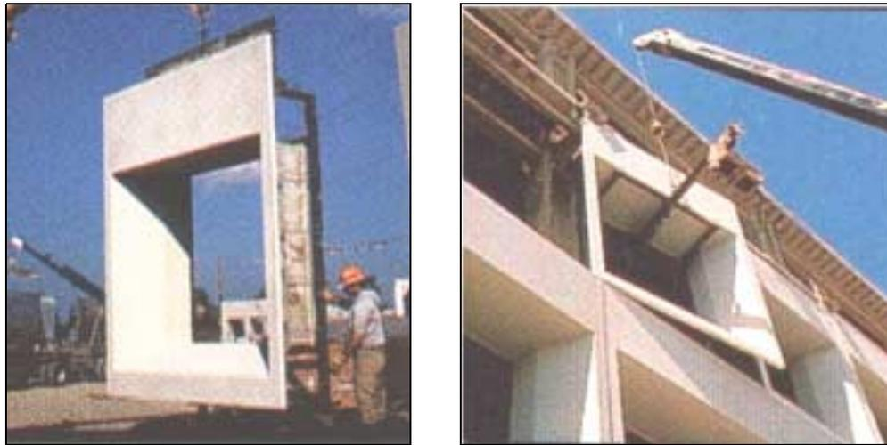
Figura 4.14: Painel com esquadria recuada em relação ao plano da fachada (PCI, 1995).
