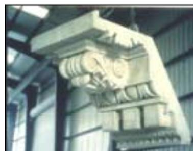
Os painéis de GRC enquadram-se no grupo de vedações leves que caracterizam-se por apresentarem densidade superficial inferior a  $100 \text{ kg/m}^2$ , por sua utilização sem fins estruturais e como elementos de fechamento interno e externo.
