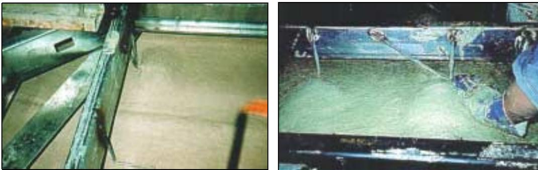
Figura 4.10: Posicionamento e incorporação do enrijecimento metálico a painéis GRC (PCI, 1995).
