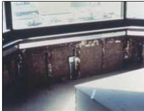
**Figura 4.2:** Passagem de tubulações na cavidade entre os painéis de revestimento e o paramento interno (PCI, 1994).
