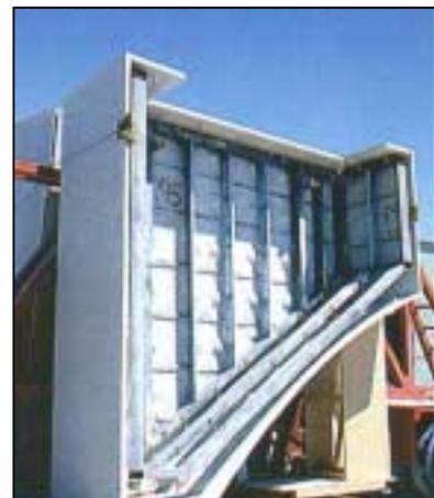
Figura 4.17: Enrijecimento metálico leve nos painéis em GRC (PCI, 1994).
