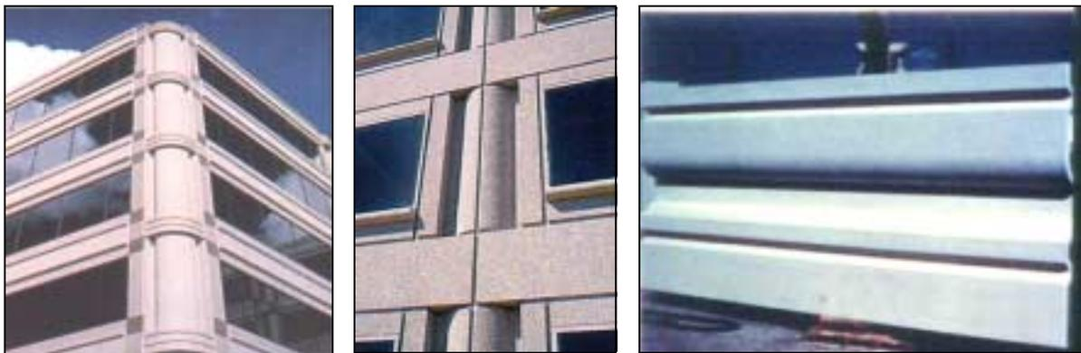
**Figura 4.13:** Flexibilidade de projeto: os painéis de cimento reforçado com fibras de vidro admitem diversas formas, cores, texturas e acabamentos (PCI, 1995).
