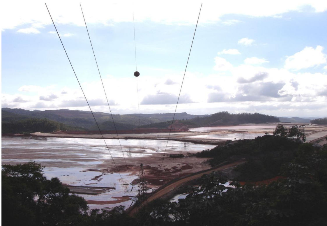
Figura 2.7.1.1 - Barragem de Rejeito SAMARCO, Mina do Germano.
