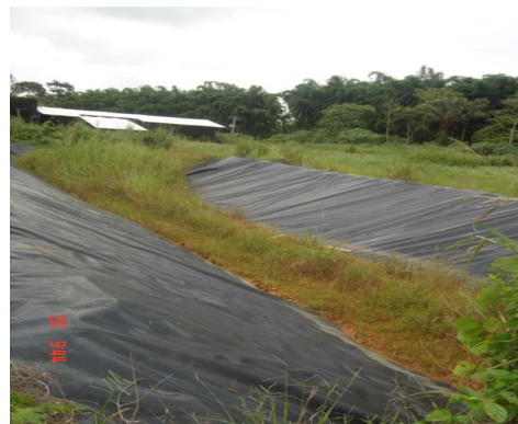
Figura 15: Vala para recebimento dos resíduos de serviço de saúde (fev.2009).
