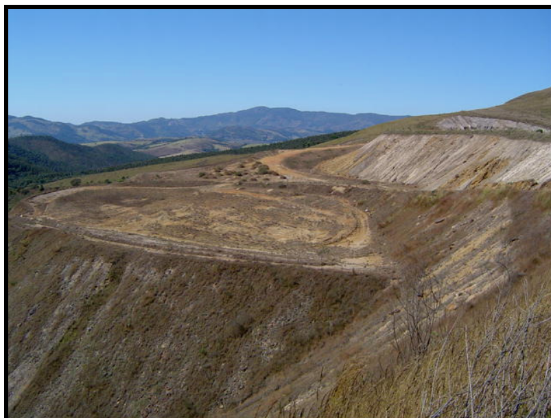
Figura 2.2 – Vista parcial do talude principal do bota-fora BF-4 (Fagundes, 2005).
