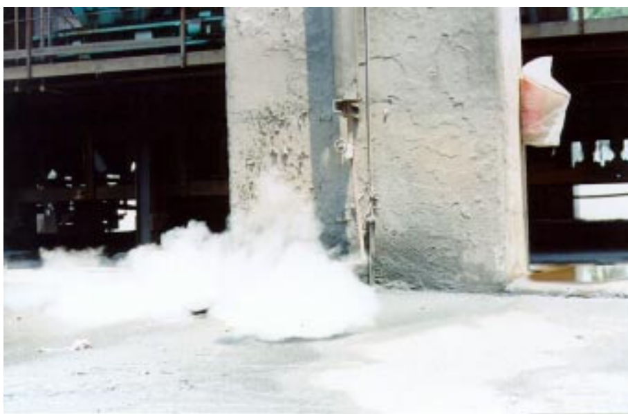
Fotografia 3.1 - Vapor atingindo pilar de concreto 13
