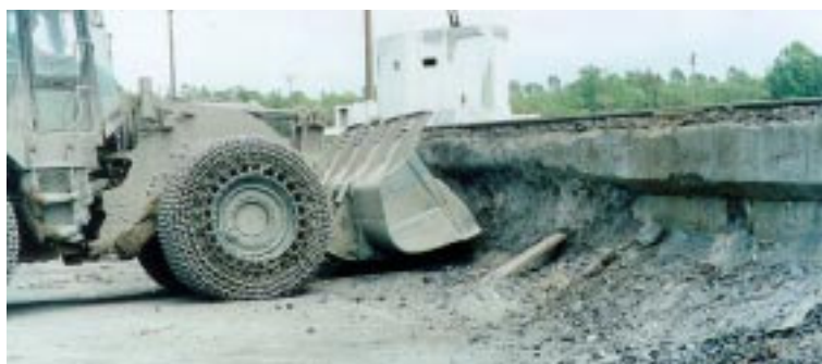
Fotografia 3.4 - Muro do Pátio de Escória e equipamento utilizado para retirada da escória resfriada atingindo o concreto por impacto 19
