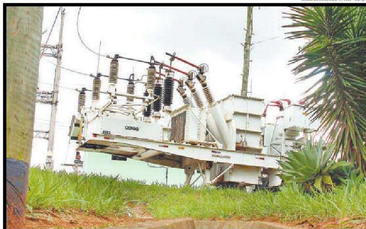
Estação móvel da Cemig em Carmópolis de Minas, que funciona como transformador de alta voltagem; ao mesmo tempo, empresa trabalha para ampliar linhas de transmissão e distribuição de energia no estado
