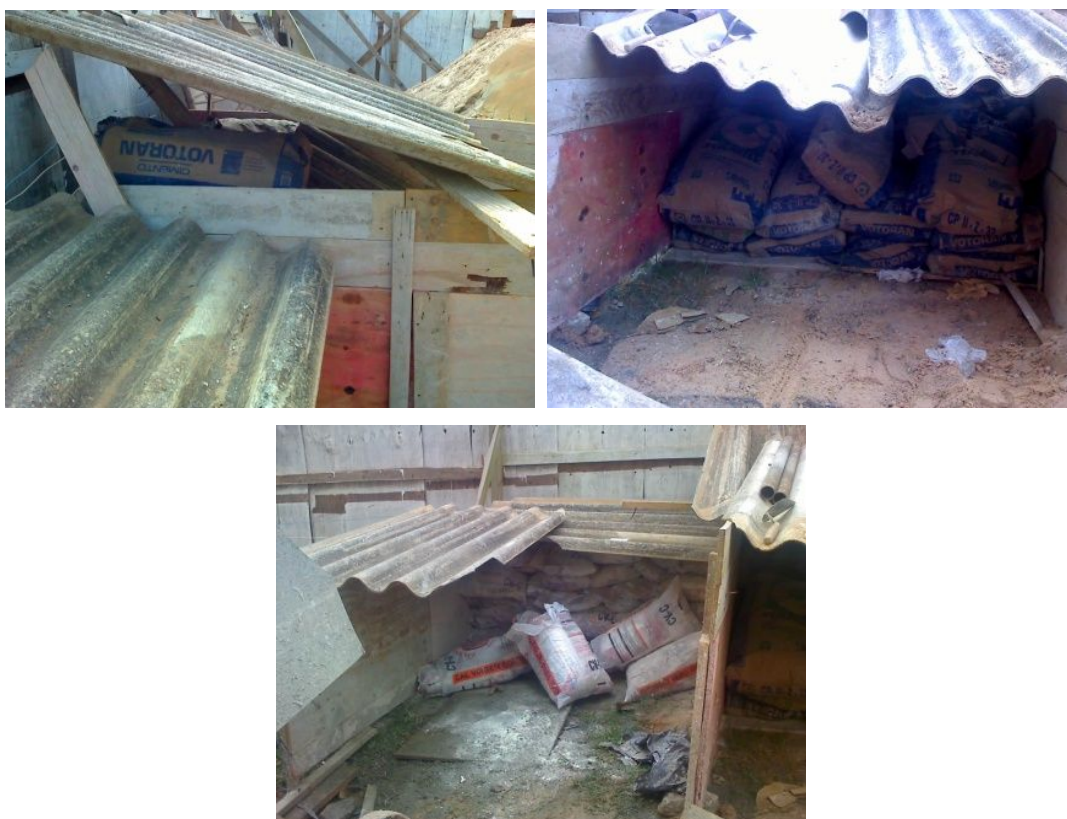
FIGURA 3.9 – BAIAS DE ARMAZENAMENTO DE RESÍDUOS
