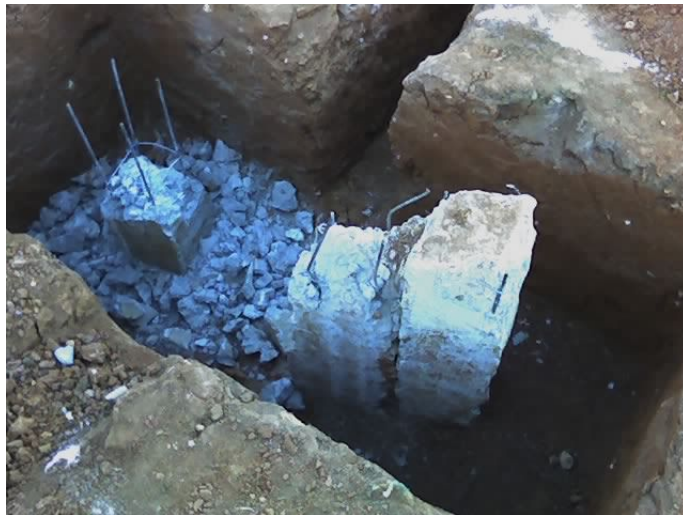
FIGURA 3.4 – ARRASAMENTO DE ESTACAS – ESTACA ARRASADA
