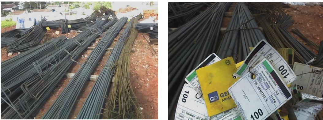
FIGURA 3.7 – AÇO CORTADO E DOBRADO
