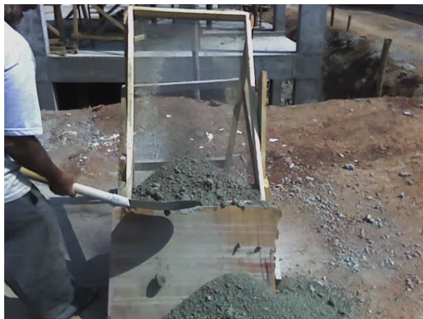
FIGURA 3.13 – PENEIRAMENTO DO RESÍDUO DE ARGAMASSA
