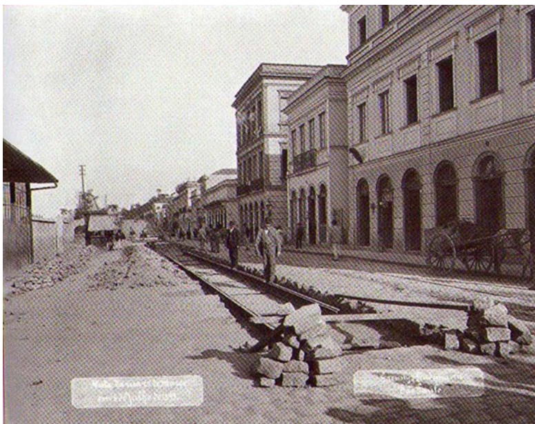
Figura 11: A imagem zero. Obras na rua 25 de Março, em 05 de julho de 1899. Gaensly & Lindemann.
