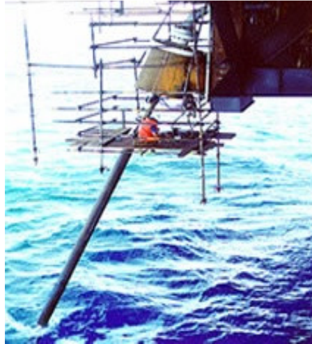
Figura I. 2: Riser rígido – plataforma P 18.
