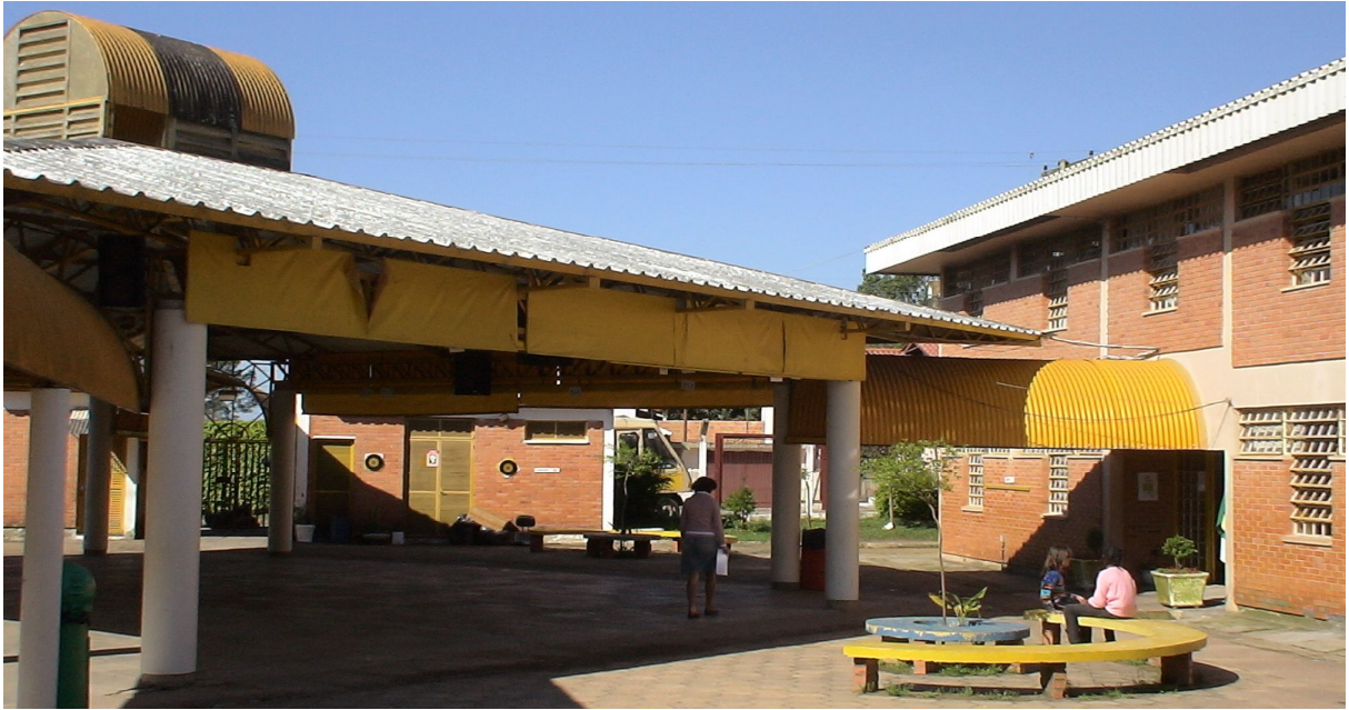
Figura 3 – Prédios e pátio da EMEF Profº Anísio Teixeira Fonte: A autora (2009)
