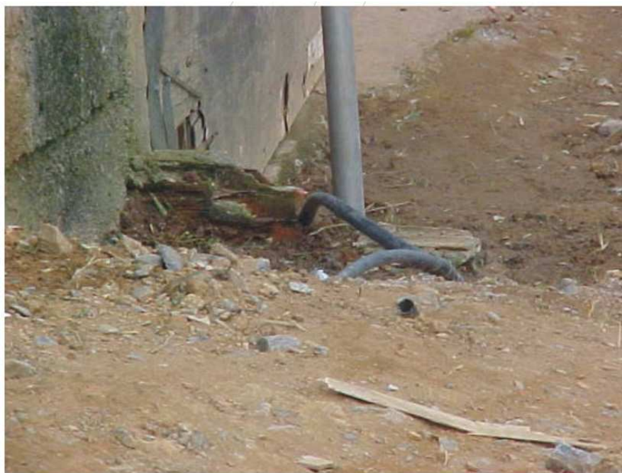
Figura 44: Desvio de água (final da Rua 1° de Maio)
