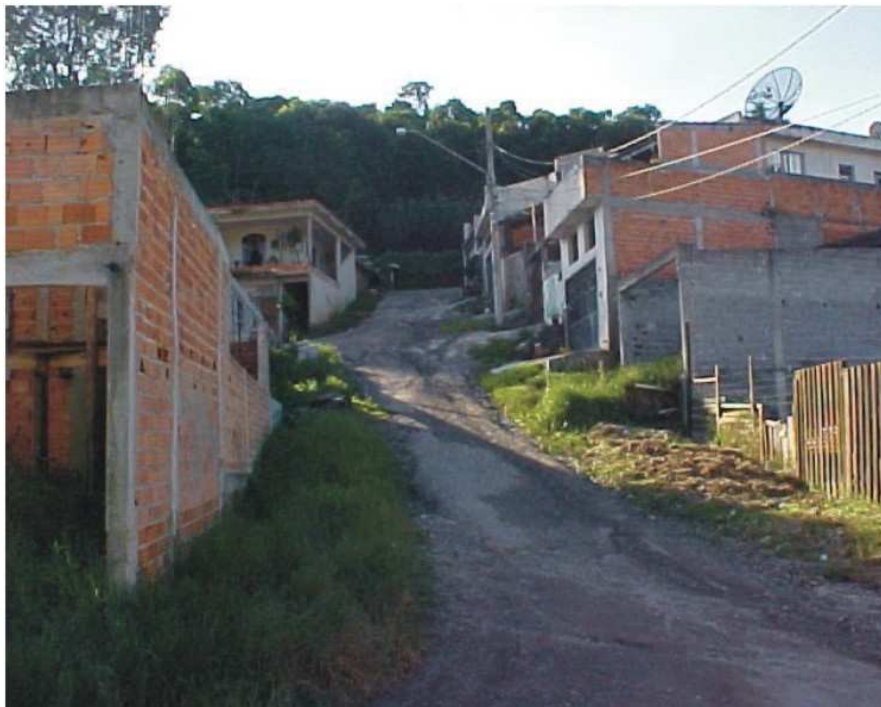
Figura 34: Vista geral da área indicada. Fonte: Prefeitura Municipal de Santo André, 2005
