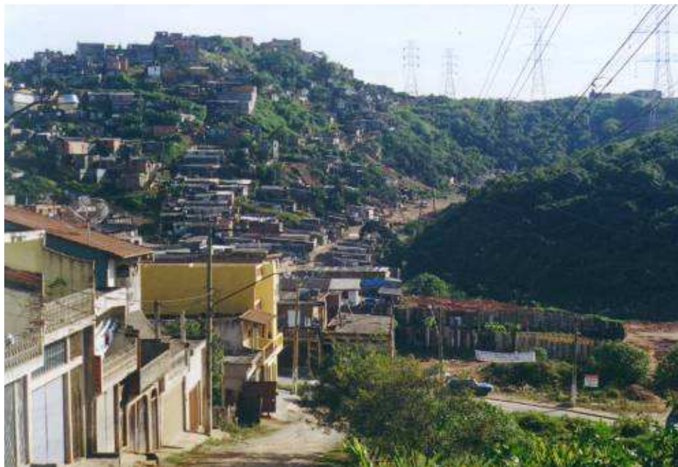
Figura 62: Vista parcial da gleba ao fundo, a partir do limite oriental da Gleba II. Toda porção extremo-oriental do morro, delimitada por via com alta declividade ao centro da foto, constitui-se em área de risco de escorregamentos. Fonte: Prefeitura Municipal de Santo André, 2005
