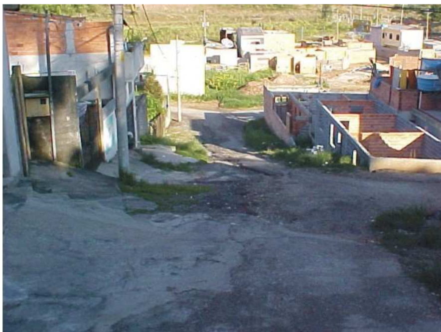
Figura 32: Vista geral da área indicada. Fonte: Prefeitura Municipal de Santo André, 2005
