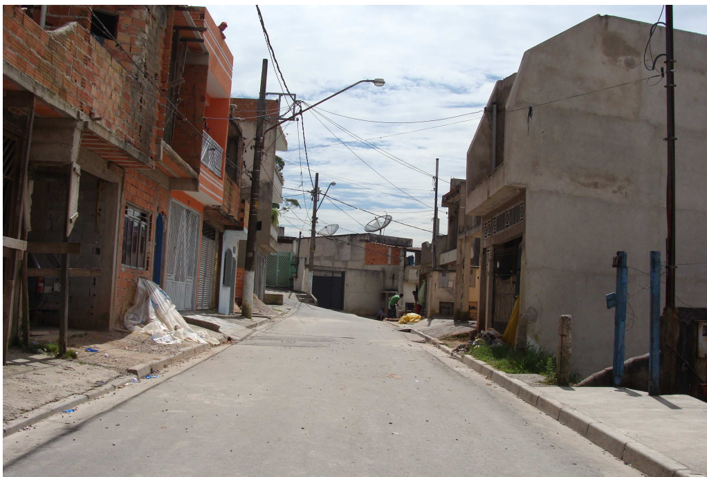
Figura 24: Caixa trafegável, guia, sarjeta e iluminação pública da Rua Águia Branca no Jardim Irene I em novembro de 2009. Fonte: Própria autora.
