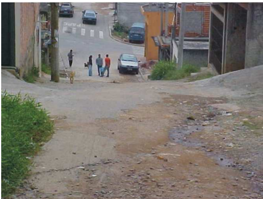
Figura 56: Ramal superficial de esgoto Fonte: Prefeitura Municipal de Santo André, 2005
