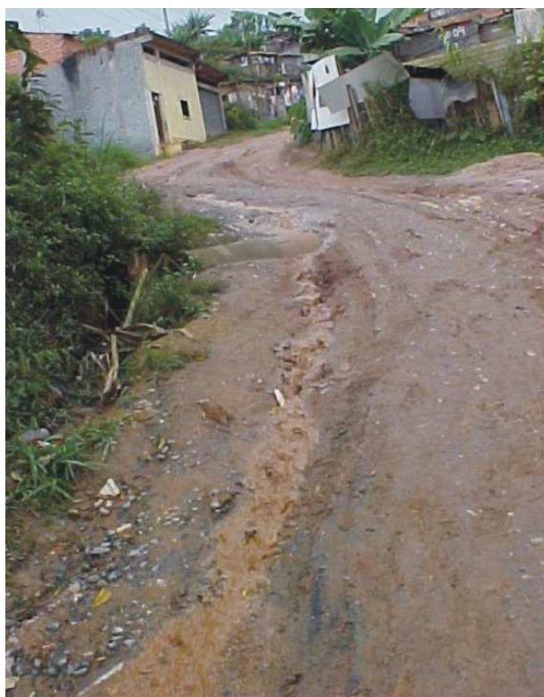
Figura 83: Esgoto lançado na rua Fonte: Prefeitura Municipal de Santo André, 2005
