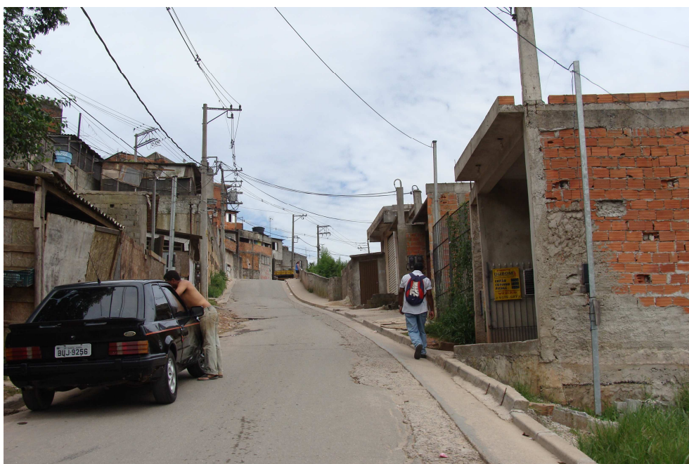
Figura 97: Rua Caminho dos Vianas , em novembro de 2009. Ao fundo vê-se o guardacorpo do muro de contenção citado. Fonte: Própria autora.
