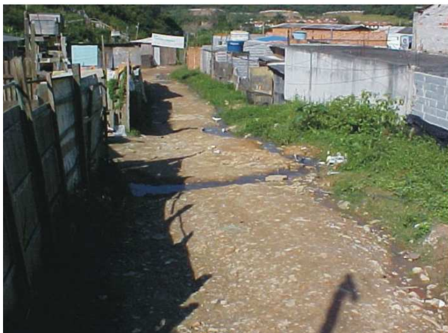
Figura 75: Lançamento de esgoto Fonte: Prefeitura Municipal de Santo André, 2005
