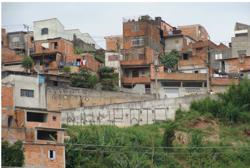
Figura 96: Muro de contenção na Rua Caminho dos Vianas , em novembro de 2009. Fonte: Própria autora.
