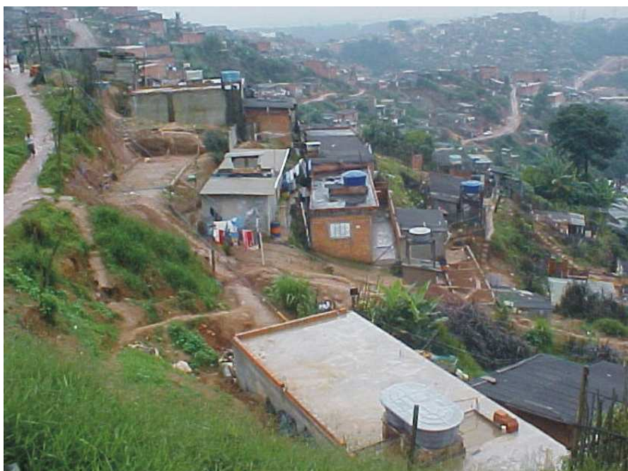
Figura 91: Ramais de esgoto e água inadequados Fonte: Prefeitura Municipal de Santo André, 2005
