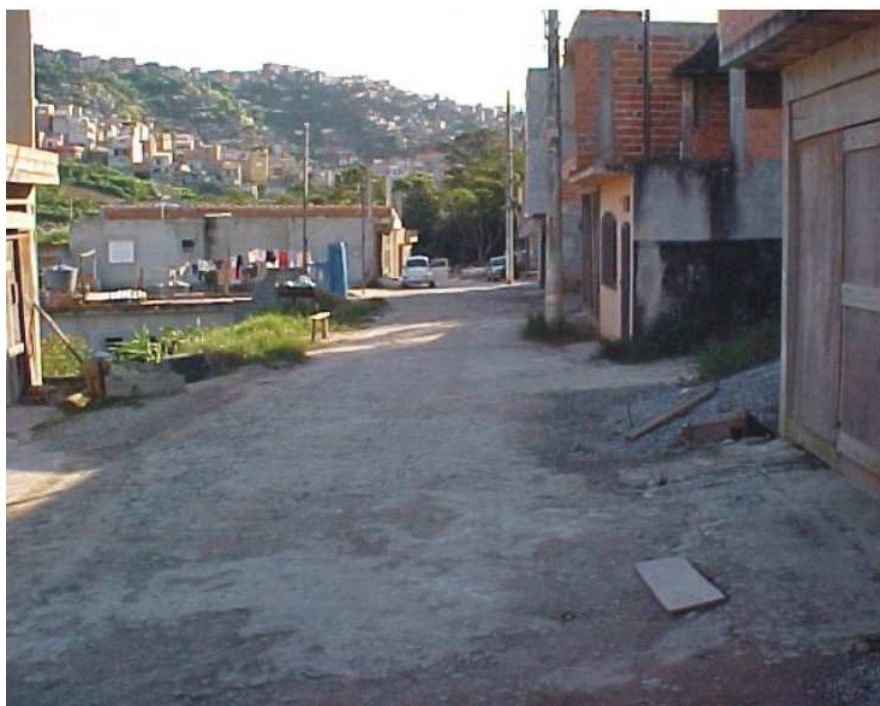
Figura 33: Vista geral da área indicada. Fonte: Prefeitura Municipal de Santo André, 2005
