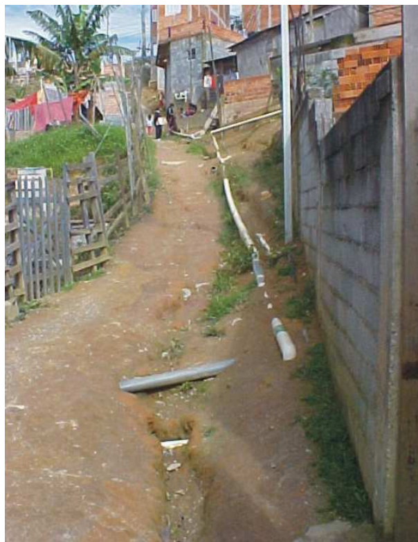
Figura 105: Ramal de esgoto implantado paralelamente à rede oficial, lançado no córrego Fonte: Prefeitura Municipal de Santo André, 2005
