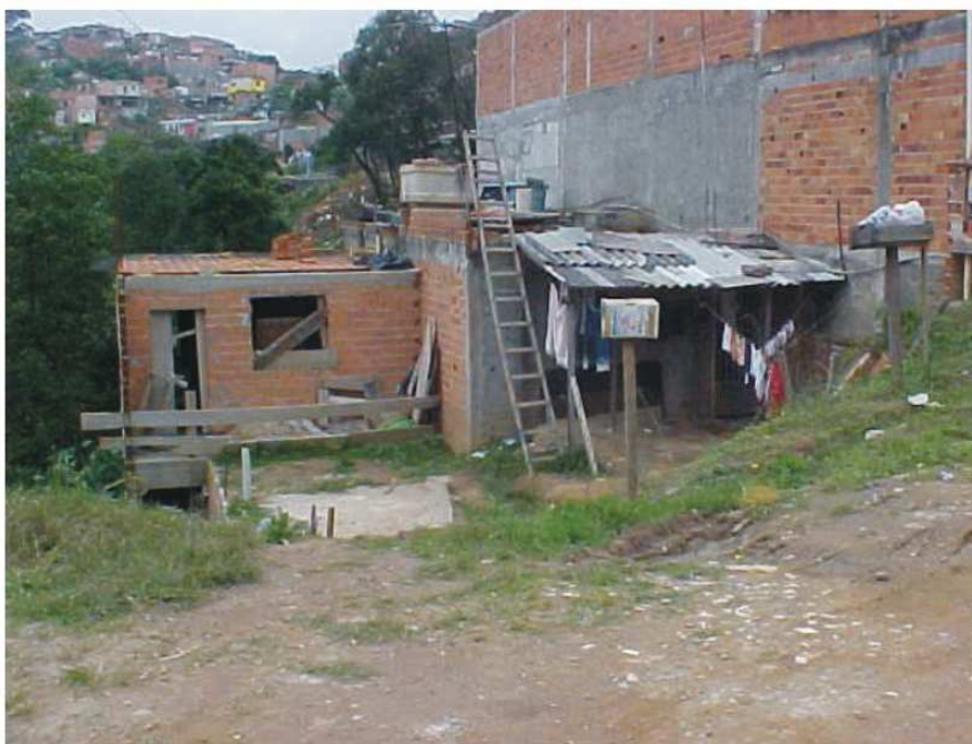
Figura 47: Vista do trecho final da Rua 1° de Maio (trecho sem rede de água) Fonte: Prefeitura Municipal de Santo André, 2005
