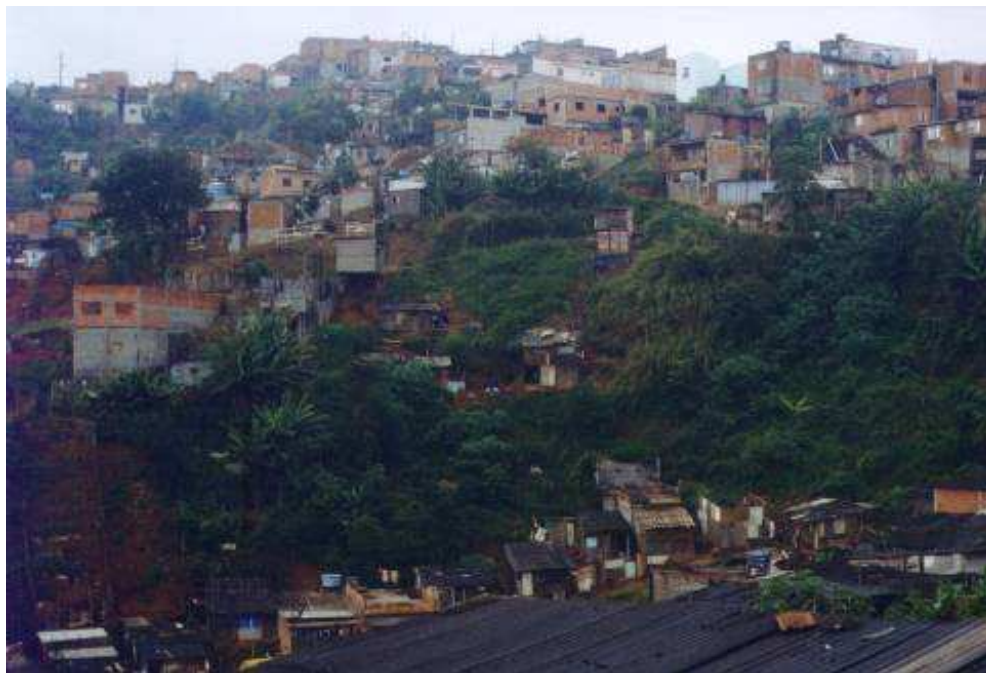
Figura 94: Áreas de risco associada à ocupação de setores de encostas relacionadas a anfiteatro de drenagem existente na porção extremo norte da gleba. Fonte: Prefeitura Municipal de Santo André, 2005.
