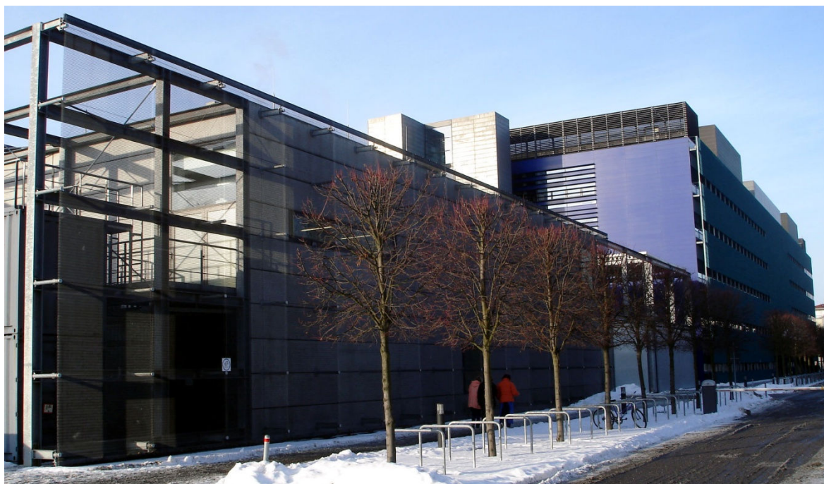
Figura 5.18. Foto externa da fachada principal do Centro C, ilustrando os volumes do edifício para criação de cobaias (primeiro plano) e volume posterior ocupado pelos laboratórios. Fonte: o autor.
