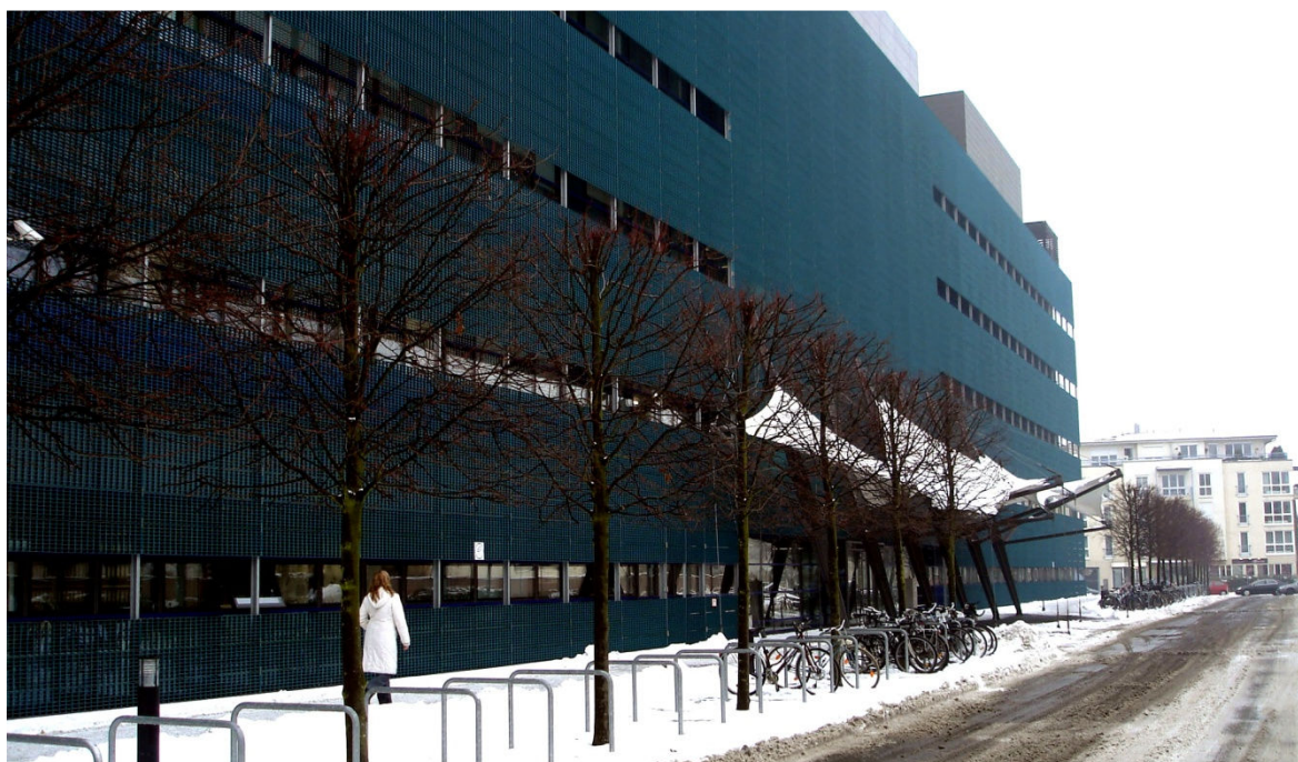
Figura 5.19. Foto da fachada do Centro C, junto à via interna de circulação e acesso principal. Fonte: o autor.
