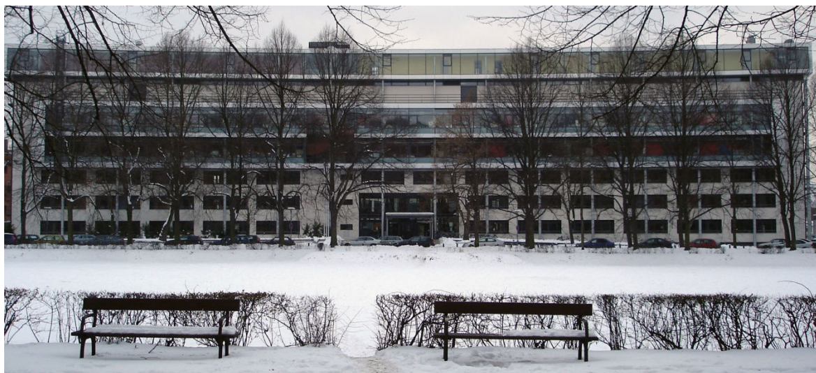
Figura 5.8. Foto externa do Centro B. Foto tirada da Deutsche Platz . Fonte: o autor.
