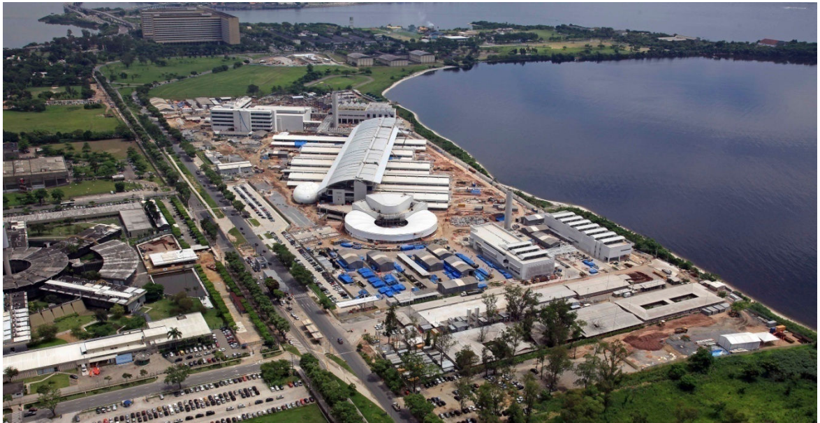
Figura 9.1. Vista geral obra da Ampliação do CENPES tirada em 12/09. Fonte: ZANETTINI, 2010.
