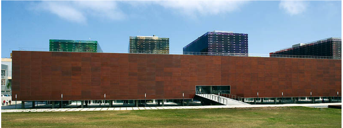
Figura 4.13. Vista externa da Cidade Politécnica da Inovação, em Valencia, ilustrando os três primeiros pavimentos ocupados por laboratórios e torres de vidro ocupadas pelas gerências e administração. Fonte: VIA-ARQUITECTURA, 2007.
