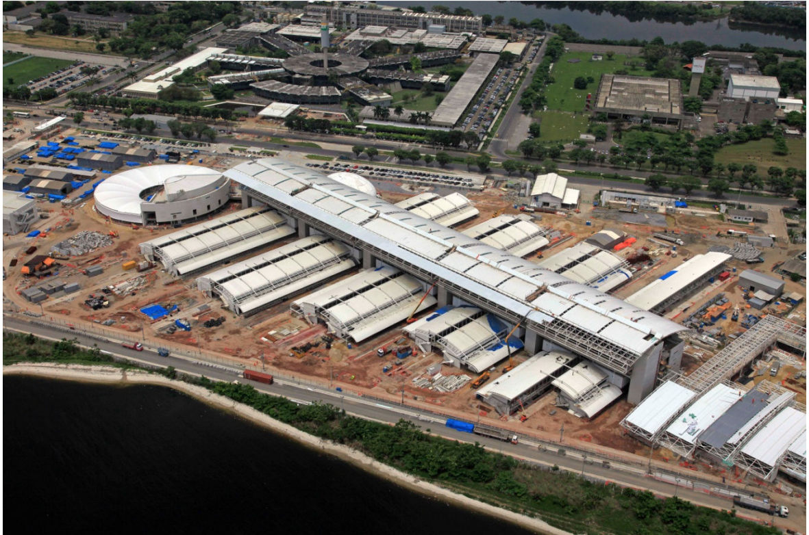
Figura 9.3. Vista da obra da Ampliação do CENPES tirada em 12/09, ilustrando a obra da Ampliação e ao fundo o edifício existente projetado por Sérgio Bernardes. Fonte: ZANETTINI, 2010.
