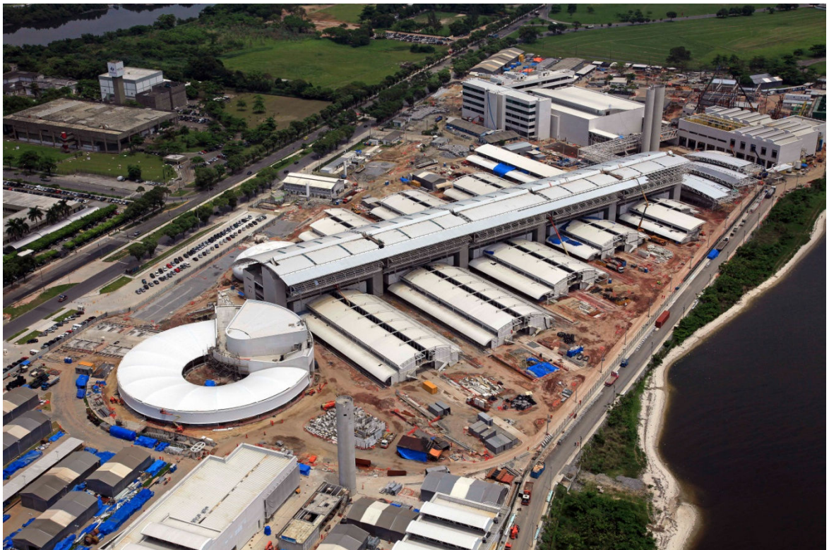
Figura 9.2. Vista da obra da Ampliação do CENPES tirada em 12/09. Fonte: ZANETTINI, 2010.
