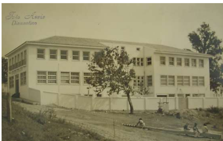
Figuras 51 e 52: Sede construída junto ao largo do Rosário. Fonte: ACI-SO n. 480 cx. 105, Módulo 038. Foto: Assis Horta.
