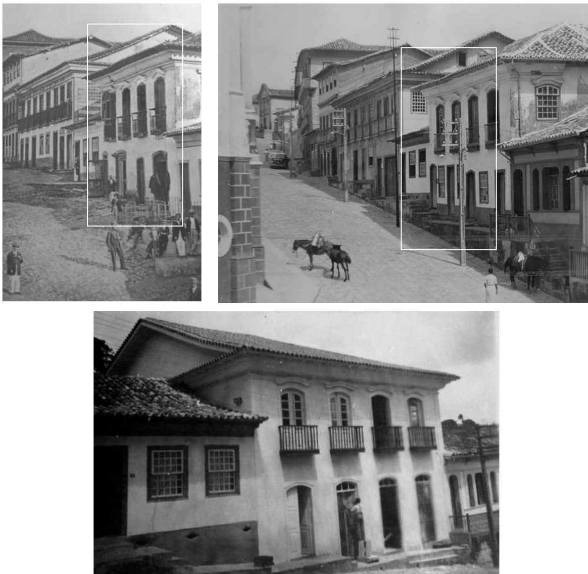
Figuras 92, 93 e 94: Sequência de trechos de imagens do sobrado à Rua Direita: registro de A. Riedel [ca.1868], e em momento anterior à intervenção, e durante a execução dos serviços [acima]. Fonte: ACI/RJ-SI.
