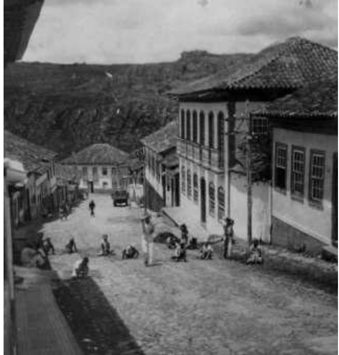
Figura 32: Operários trabalhando na substituição do calçamento da via em 1948. Fonte: ACI/RJ.
