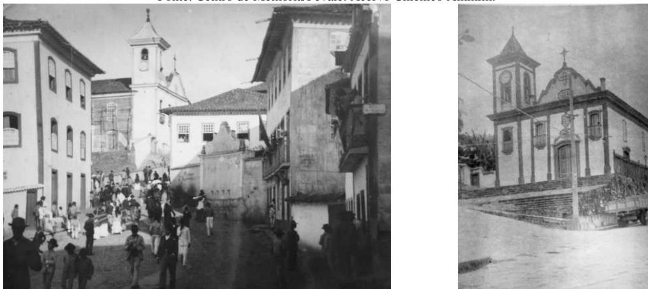
Figuras 13 e 14: À esquerda, ao fundo, igreja de Santo Antônio, e à direita, igreja de São Francisco com sua escadaria frontal. Fonte: CDI/13 a SR-IPHAN/MG (fig. 14 Foto: Assis Horta, 1966).
