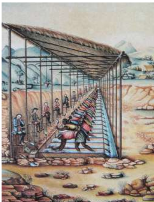
Figuras 1 e 2: Os diamantes eram encontrados mais facilmente no aluvião dos rios. Quando este se esgotava, passava-se à exploração dos depósitos de cascalhos (grupiaras), junto às margens.
