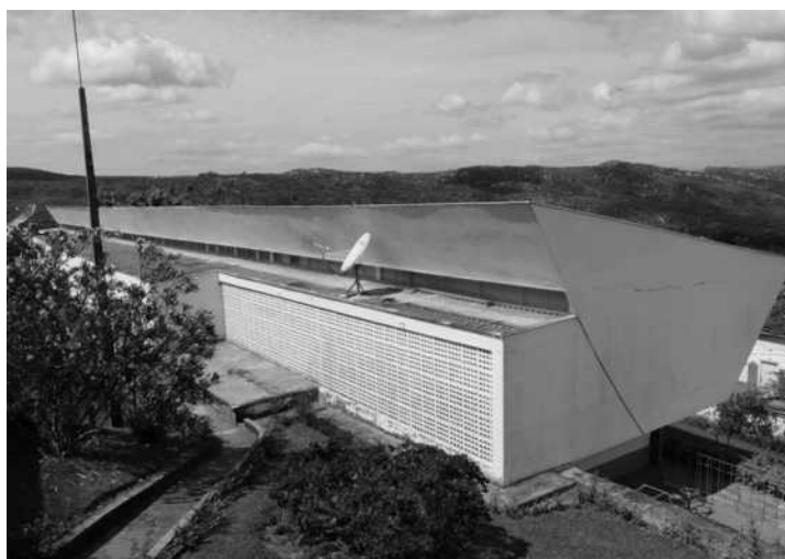
Figuras 137, 138 e 139: Vista da circulação com elemento vazado parcialmente obstruído, painel de Portinari e vista superior, com paisagem de Diamantina ao fundo. Observar, acima, a linha de janelas que proporcionam ventilação cruzada às salas de aula. Fonte: acervo da autora, 2009.
