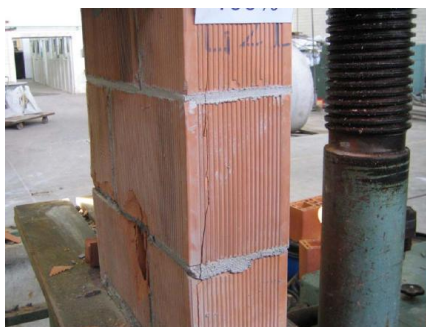
Figura 2.39 - Formação da fissura na face transversal do bloco - Grohmann (2006)
