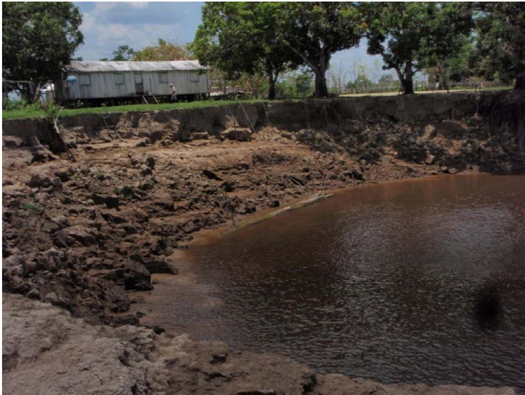
Figura 7.45- Movimento de massa que causou a desativação da estação fluviométrica Porto União.
