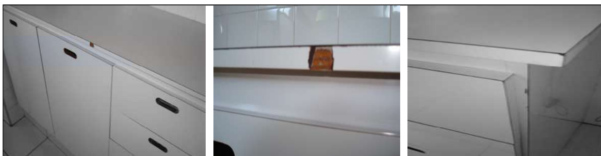
Ilustr. 44- Detalhes de acabamento de topo com laminado plástico. Fotos do autor.
