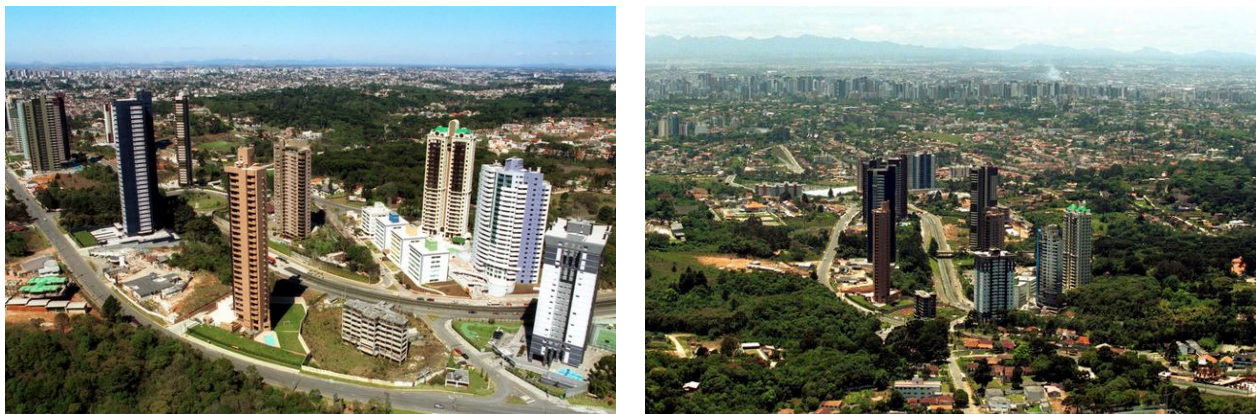
Figura 12: Fotos da verticalização do Ecoville (Setor Especial Nova Curitiba)
