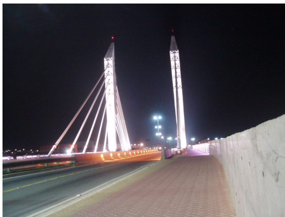
Figura 61 – Fotografia 8 - Ponte sobre o rio das Ostras, na RJ 106. Em 2007. Fonte: Autora, junho de 2007.
