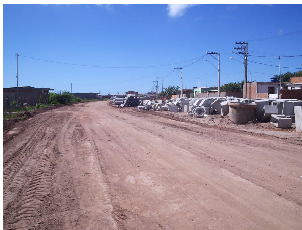
Figura 54 – Fotografia 6. Loteamento Âncora, 2008, com obras de pavimentação e drenagem. Fonte: Autora, março de 2008.
