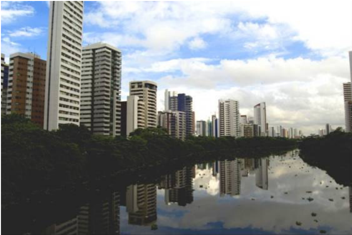
Figura 3.14: Edifícios nas Margens do rio Capibaribe no Bairro da Madalena
