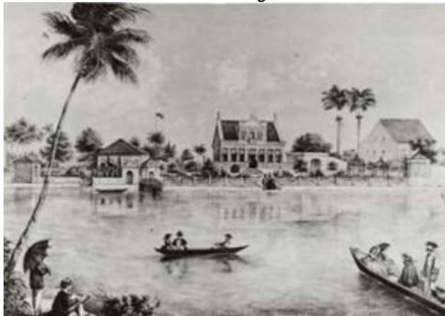
Foto 3.9: Parte da Passagem da Madalena
