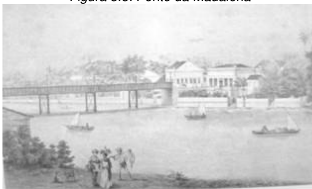
Figura 3.8: Ponte da Madalena
