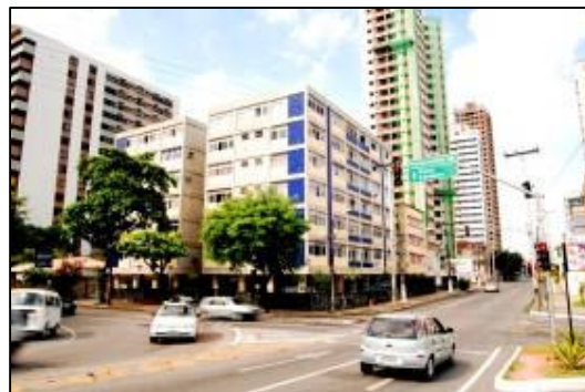
Figura 4.2: Edifício Duas Nações
