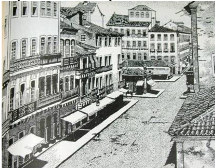
Figura 3.4 Sobrados Altos e Magros no Bairro de Santo Antônio
