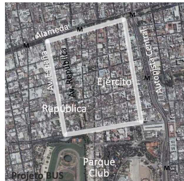
Perímetro Proyecto Barrio Universitario. Elaboração própria. Fonte da imagem de satélite: Google Maps, 2009.
