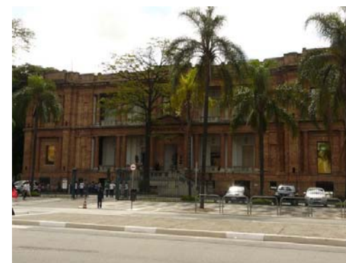
Edifício da Pinacoteca do Estado
