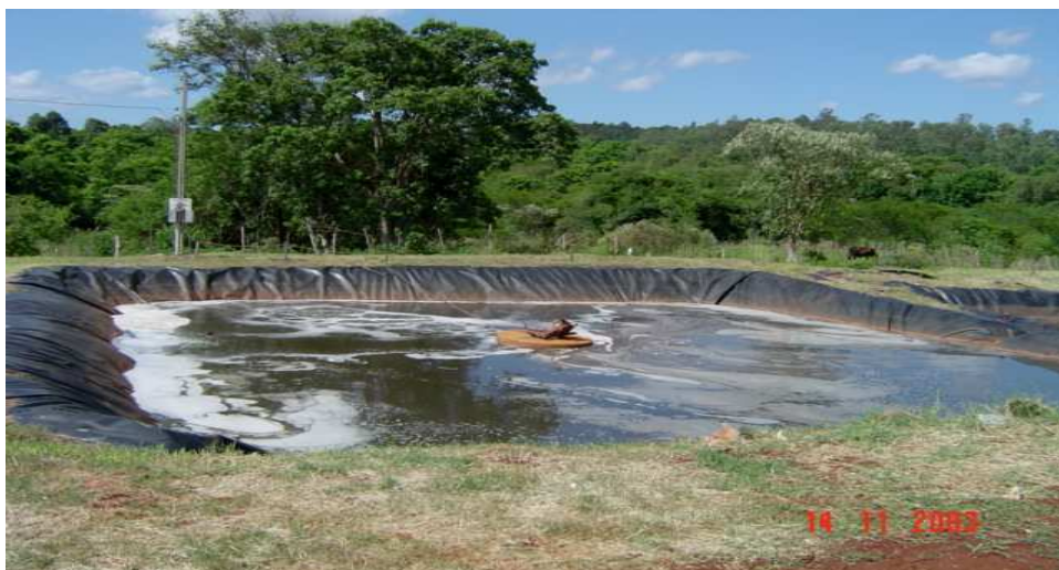
Figura 8 - Primeira lagoa de retenção de chorume (Fonte: SEMA).
