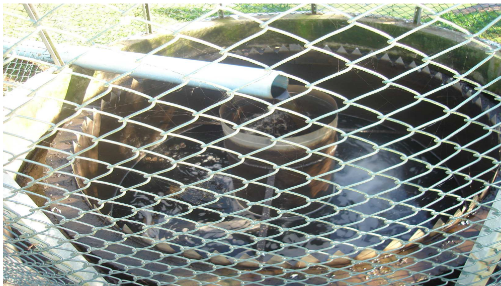
Figura 3 – Decantador da estação de tratamento do chorume do aterro sanitário de Lajeado – bairro Conventos (Fonte: SEMA).
