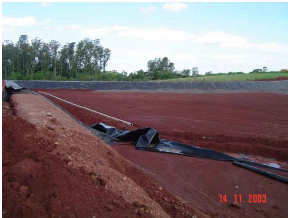
Figura 10 - Instalação da nova célula (Fonte: SEMA).
