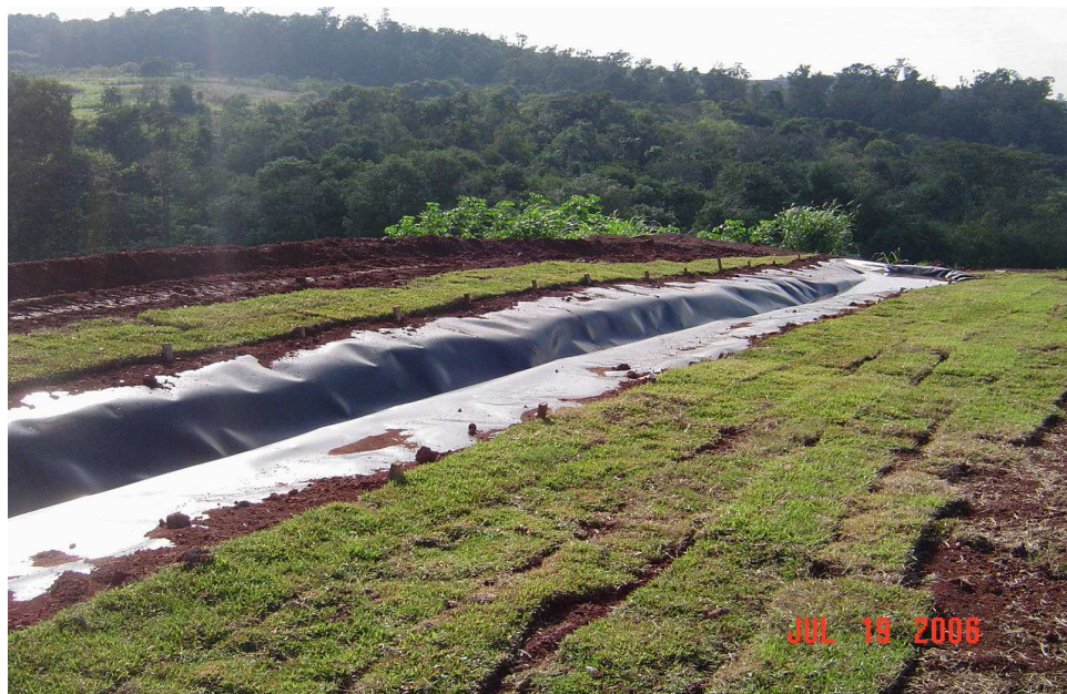
Figura 11 - Finalização da recuperação do antigo lixão (Fonte: SEMA).
