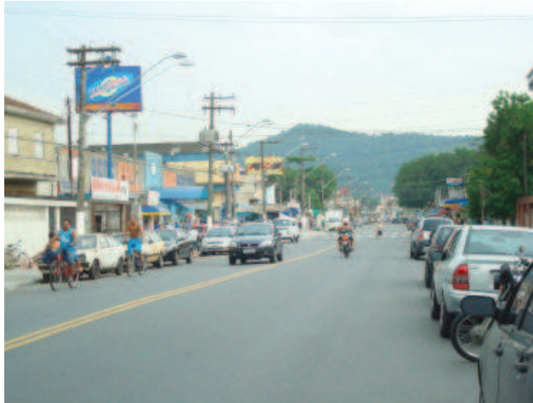
Figura 16 Vista da avenida Álvaro Guimarães, local de intenso comércio
