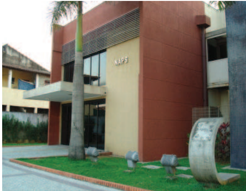
Fig.1 Visão panorâmica da entrada do prédio do NAPS
