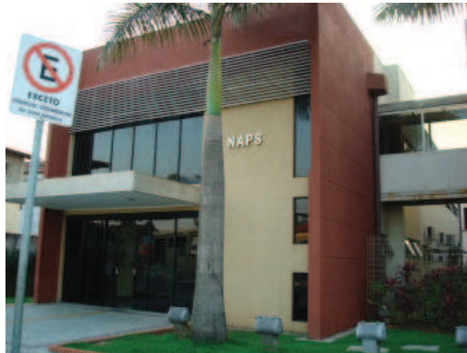
Figura 3 Visão do prédio do NAPS I e sua ligação lateral, com o Complexo Hospitalar da Zona Noroeste.
