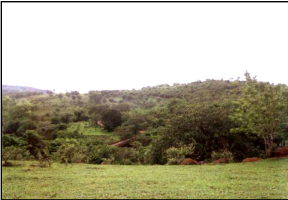
Fig. 24 - Ponte do Pau Furado já desativada em função das obras da UHE de Capim Branco I e II. Uberlândia-MG. Autora: Ferreira (Agosto/2003).
