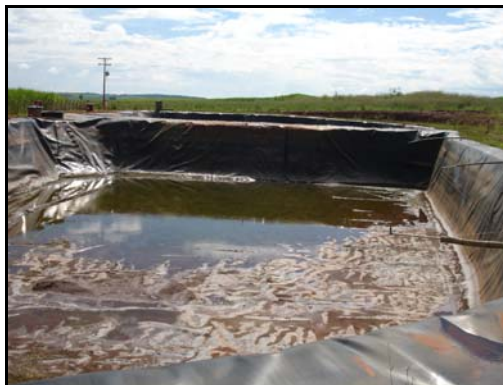
Figura 25. Vista parcial das lagoas de lixiviado ao Aterro Meridiano.
