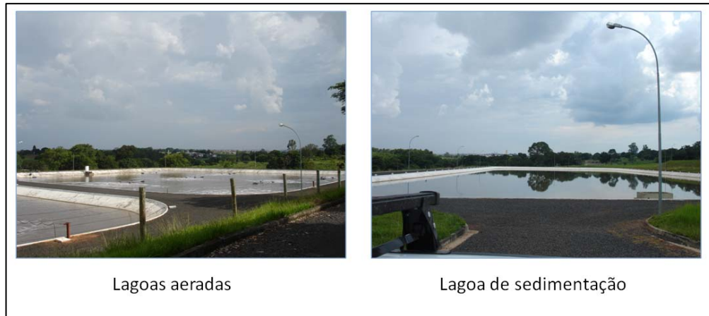
Figura 36. Vista parcial das lagoas aeradas e de sedimentação da ETE Tupã
