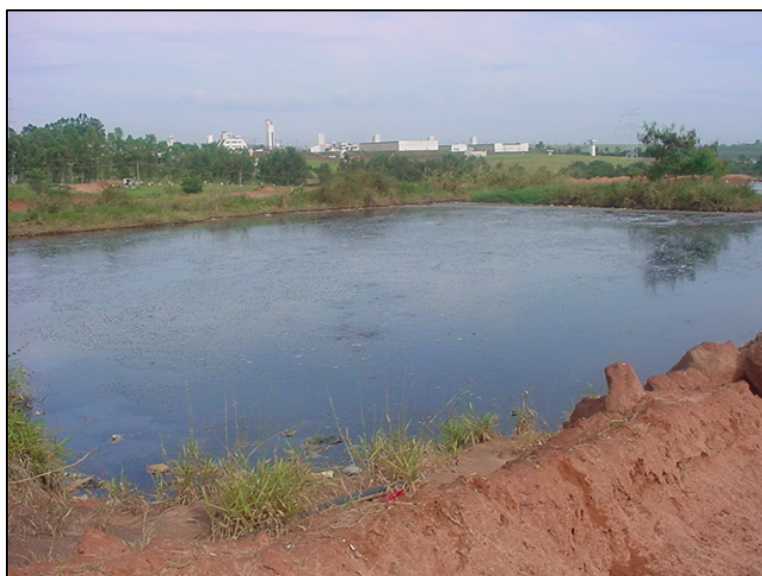
Figura 13. Lagoa de recirculação situada sobre a célula do aterro.
