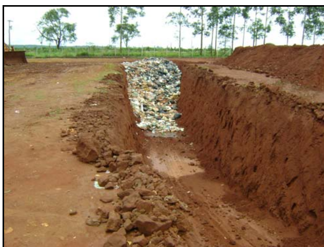
Figura 9. Aterro em valas. Vala em utilização.
