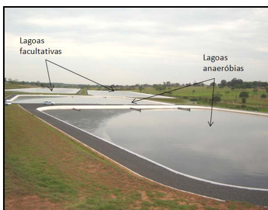
Figura 54. Vista parcial das lagoas de estabilização da ETE 2 Fernandópolis
