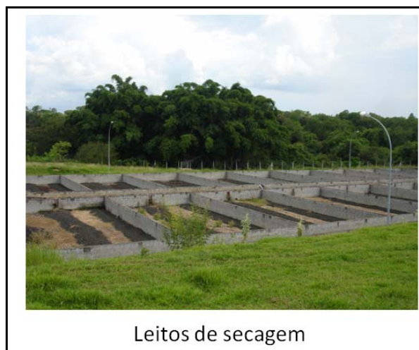
Figura 37. Vista parcial dos leitos de secagem de lodo da ETE Tupã - SP
