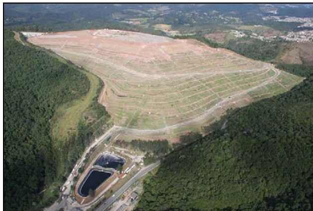
Figura 32. Aterro São João.
