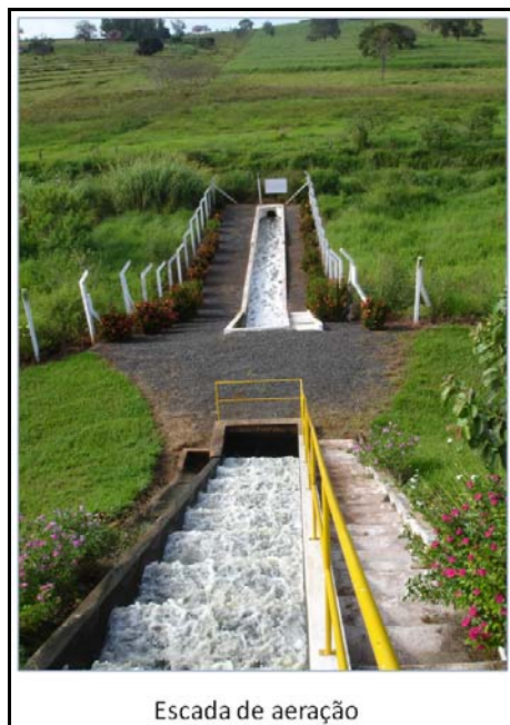
Figura 55. Escada de aeração da ETE 2 Fernandópolis.
