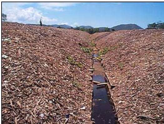
Figura 21. Sistema de drenagem - Aterro da Baleia.
