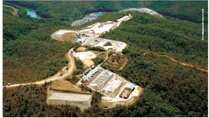
Visão aérea do canteiro de obras de Batalha
