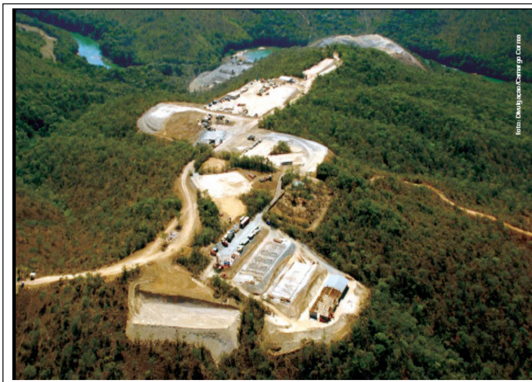
Ilustração 1 – Canteiro de obras do empreendimento BATALHA no Rio São Marcos. Foto retirada da revista FURNAS, p.15 – ano XXXIV. N. 356 – Setembro de 2008.
