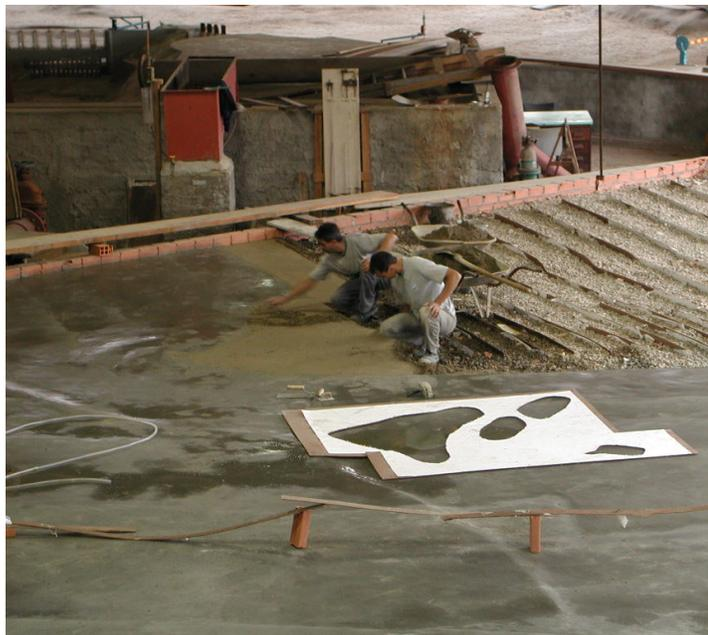
FIGURA 18 – ETAPAS DA CONSTRUÇÃO DO MODELO FÍSICO – ACABAMENTO DA SUPERFÍCIE
