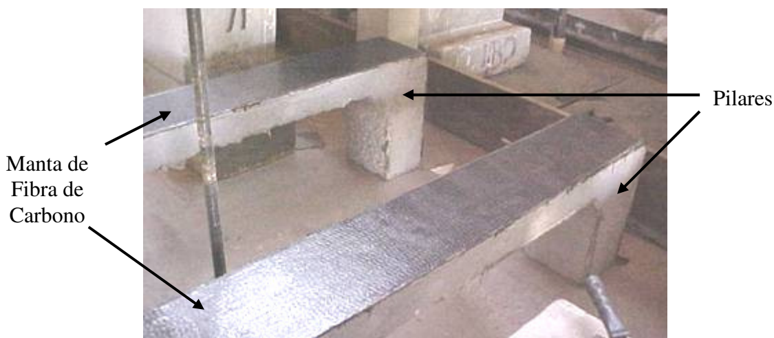
Figura 2.10 – Pilares reforçados com compósito de fibra de carbono (NASCIMENTO, 2006)
