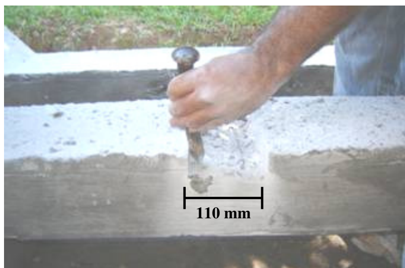
Figura 3.13 – Processo de descobrimento da armadura, abertura do sulco
