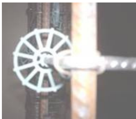
Figura 3.8 – Espaçadores utilizados nas armaduras
