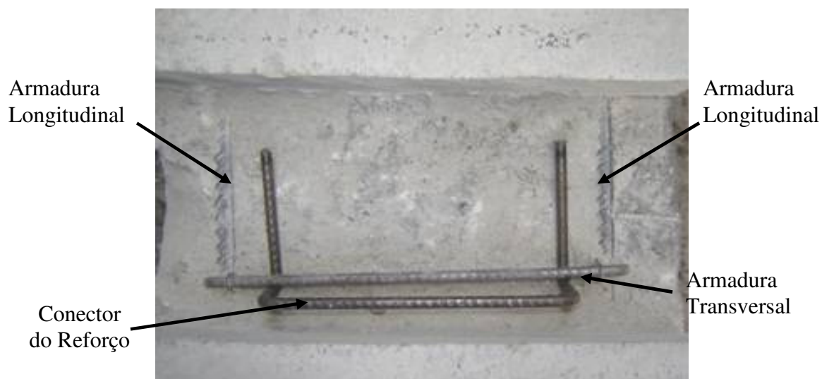
Figura 3.14 – Colocação dos conectores do reforço
