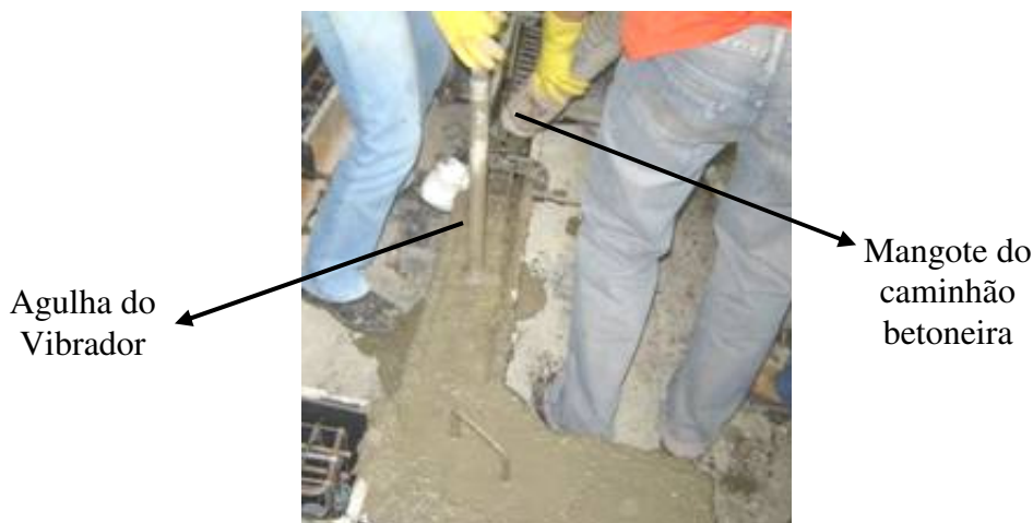
Figura 3.10 – Concretagem e adensamento dos pilares
