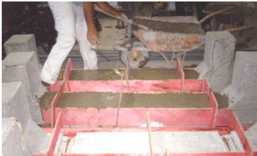
Figura 3.16 – Concretagem do reforço com CAA
