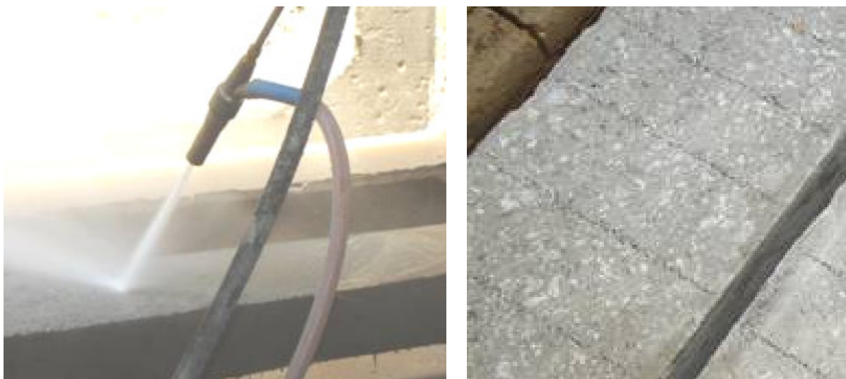
Figura 3.12 – Procedimento de escarificação dos pilares com jato de areia e superfície escarificada
