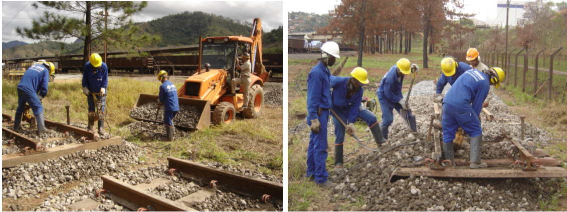
Figura 3.18 – Construção das seções do simulador.
