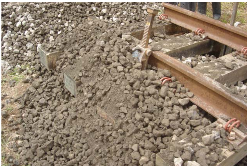
Figura 5.2 – Excesso de finos presentes na escória utilizada na construção do simulador.
