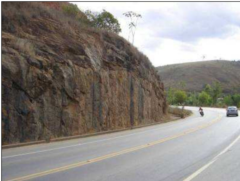
Figura 4.21 – Visão geral da seção BR-259, onde se observa o maior fraturamento na porção superior do maciço.
