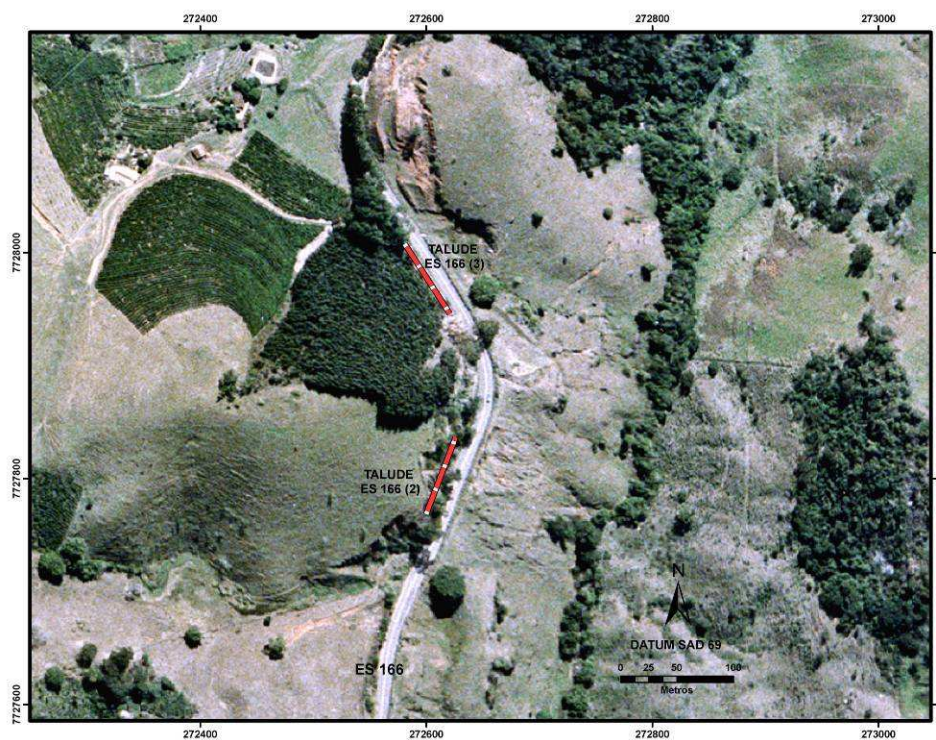
Figura 4.13 – Vista aérea dos taludes ES-166 (2) e ES-166 (3).
