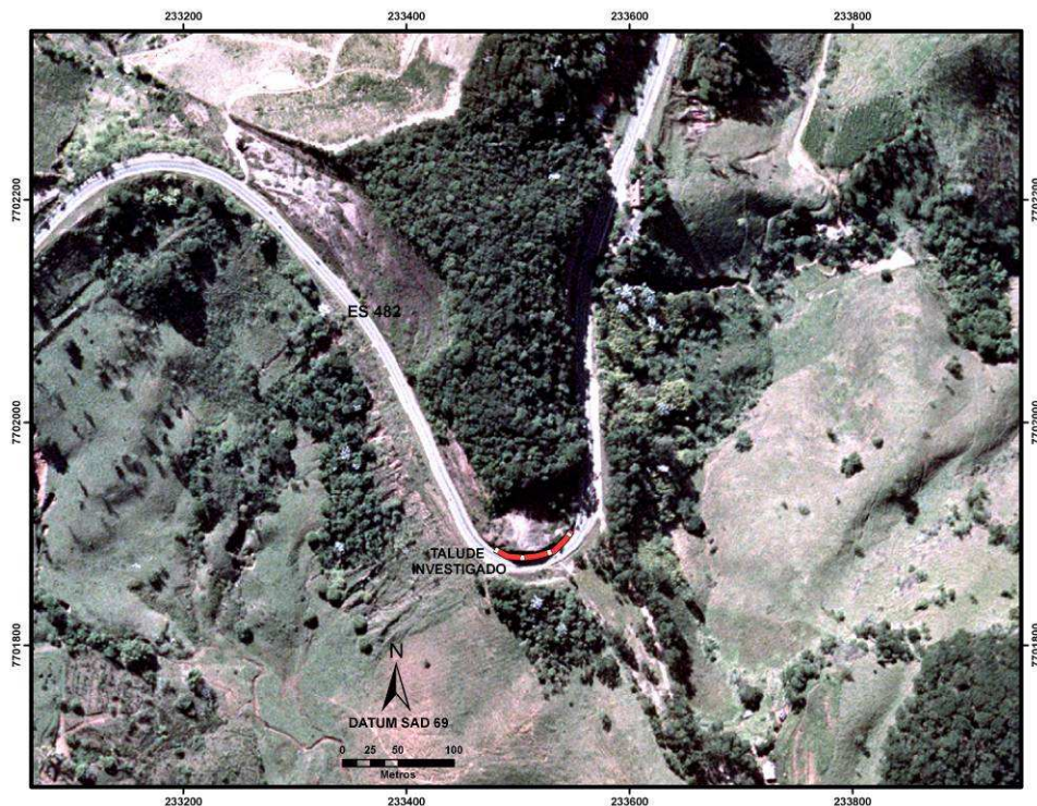
Figura 4.18 – Imagem aérea do talude ES-482, situado em forte curva horizontal.
