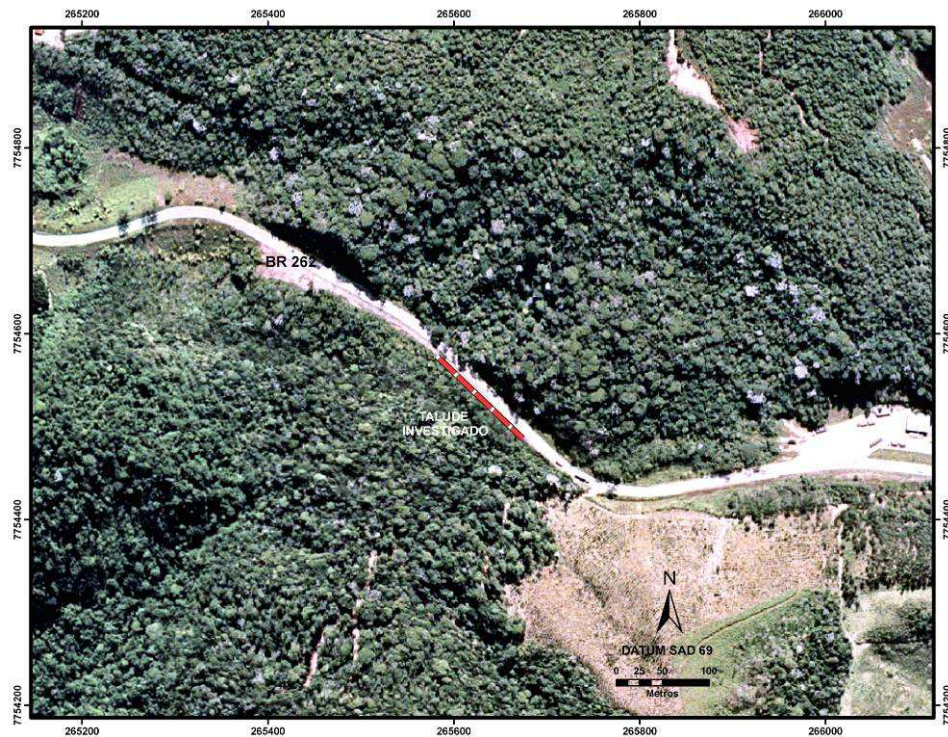
Figura 4.22 – Imagem aérea do talude BR-262, município de Conceição do Castelo.
