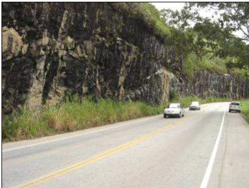
Figura 4.23 – Vista geral do talude investigado na BR-262.
