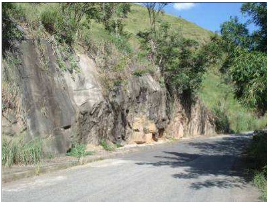
Figura 4.15 – Vista parcial do talude ES-181.
