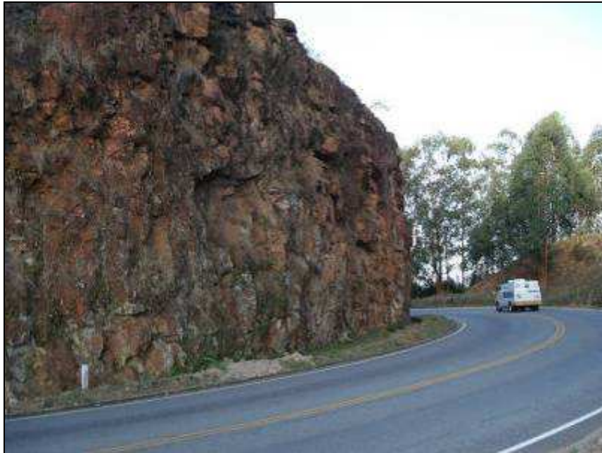
Figura 4.19 – Vista parcial do talude ES-482.
