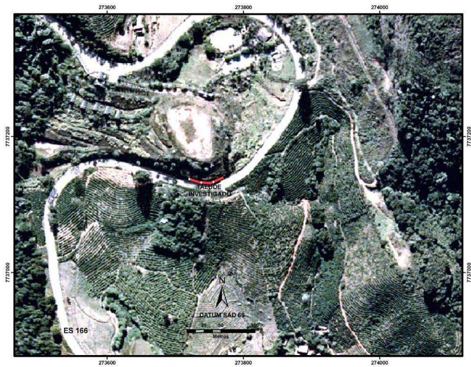
Figura 4.9 – Vista aérea do talude ES-166 (1), onde nota-se a sinuosidade da geometria do segmento rodoviário.
