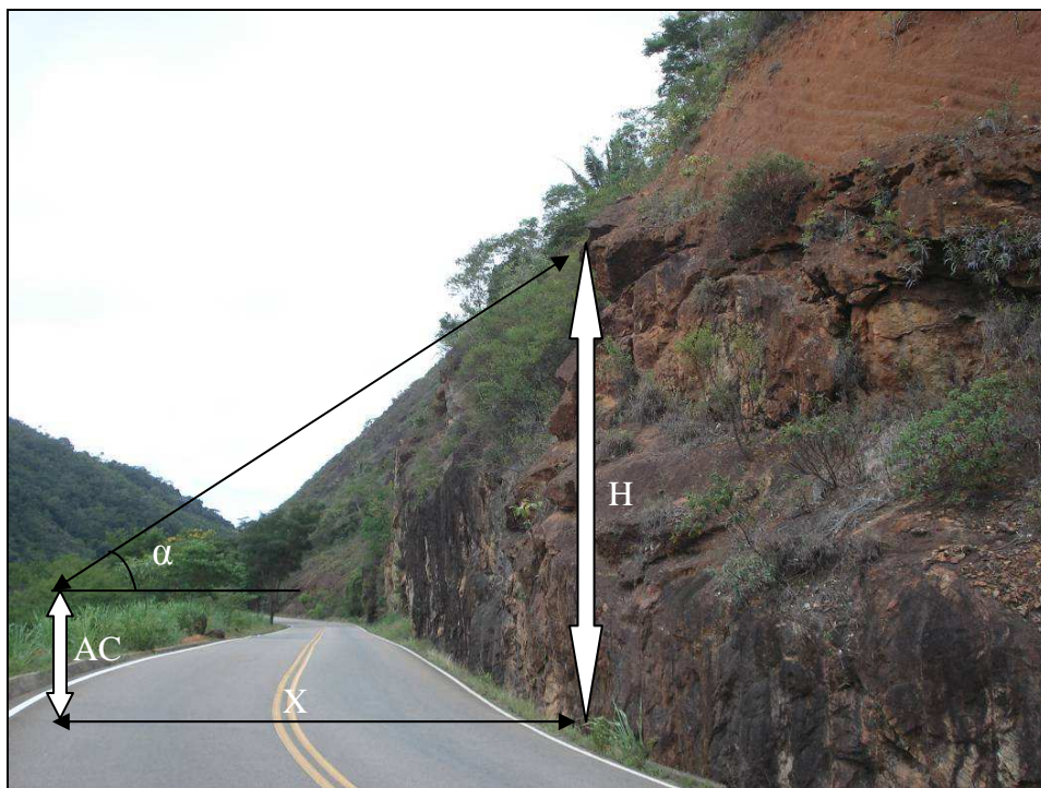
Figura 5.1 – Esquema utilizado para cálculo da altura do talude através de relação trigonométrica.
