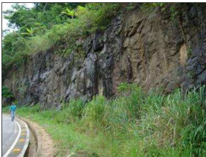
Figura 4.6 – Vista de parte do talude da rodovia ES-146.
