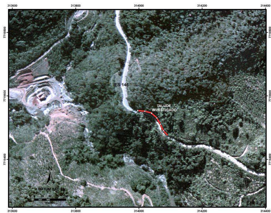
Figura 4.5 – Fotografia aérea da região do entorno da seção ES-146.
