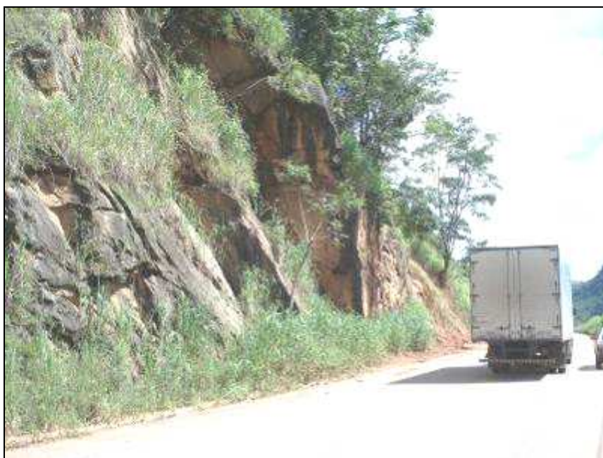
Figura 4.11 – Vista parcial do talude ES-166 (2).
