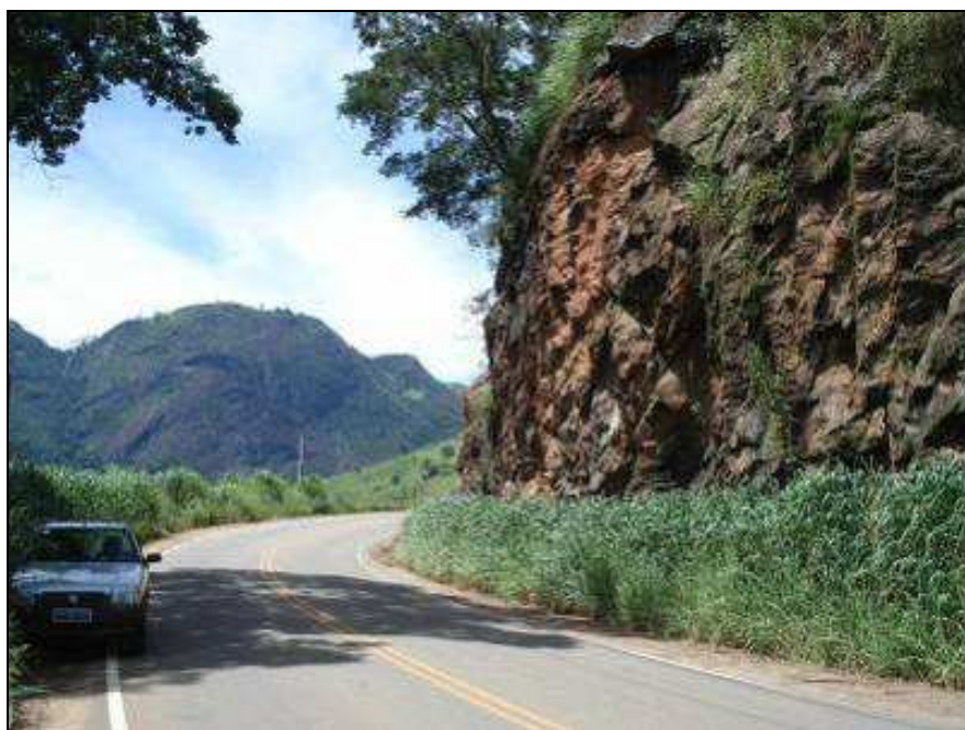
Figura 4.12 – Vista parcial do talude ES-166 (3).
