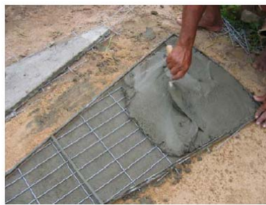
(b) Colocação do concreto.
