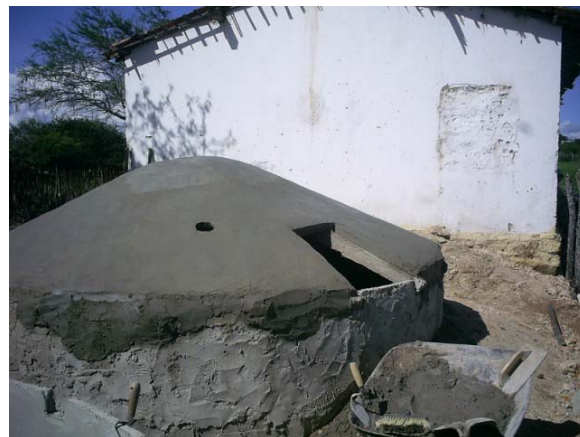
(f) Revestimento das cisternas
