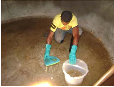
(a) Limpeza do interior da cisterna.
