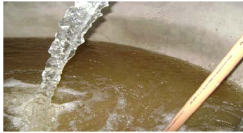
(b) Enchimento da cisterna
