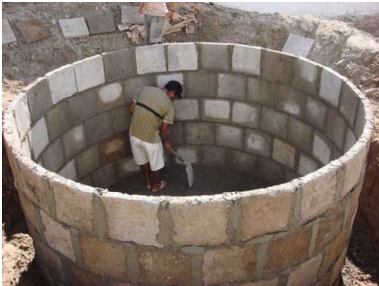
(c) Assentamento das placas das paredes
