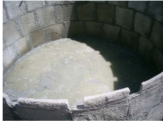
(d) Revestimento das paredes
