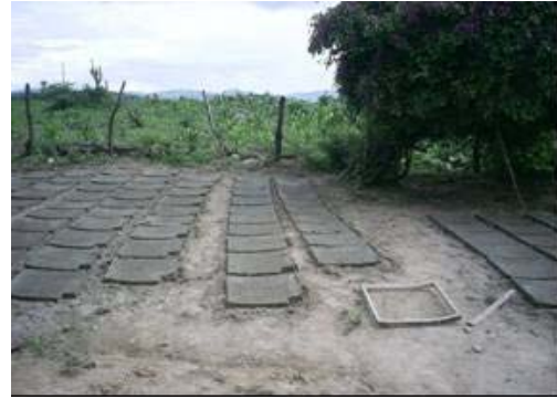
(b) Confecção das placas das paredes
