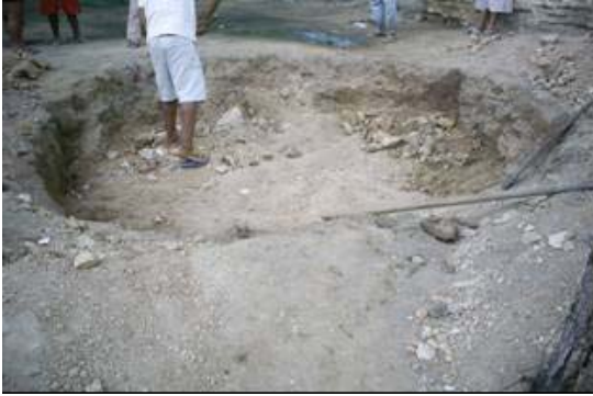
(a) Escavação manual
