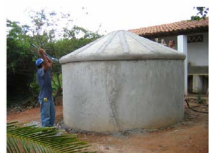
(c) Cisterna construída.
