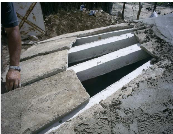
(e) Assentamento das placas do teto
