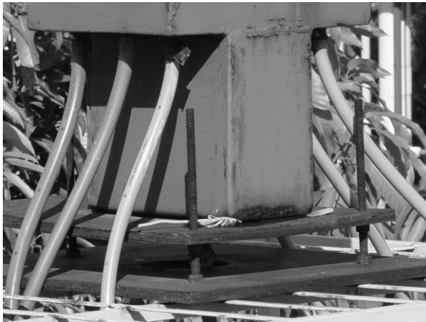
Figura 4.12 – Caixa distribuidora de vazão com parafusos ajustáveis
