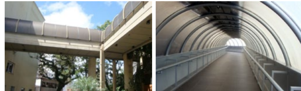
Fig.41 Fotos ilustrativas das passarelas que ligam os hospitais do complexo da Santa Casa de Porto Alegre. Fonte: acervo pessoal.
