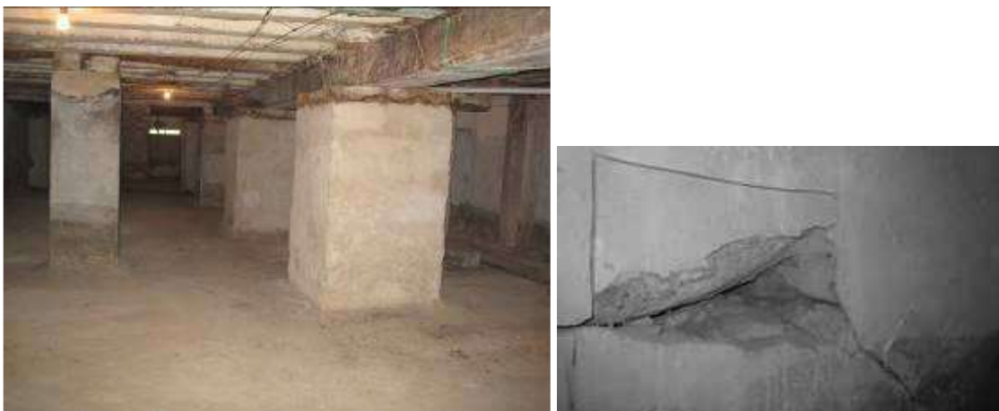
Figura 31: Foto do porão atual (sede alta) com pé-direito reduzido, pilares e paredes rebocados; detalhe (foto à direita): parte da parede rebocada expondo a pedra original
