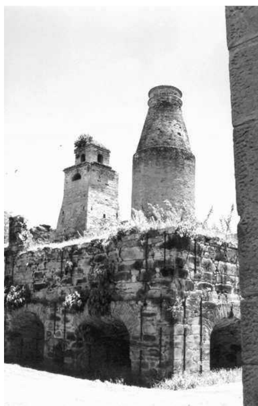
Figura 11: Altos fornos da Real Fábrica de Ferro São João de Ipanema, Iperó.
