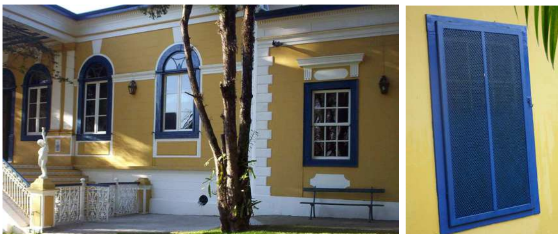
Figuras 97 e 98: À esquerda, janelas de arco pleno da sede alta; ao centro, janelas de verga reta da sede baixa e, à direita, janela da sede baixa com treliça, na cozinha
