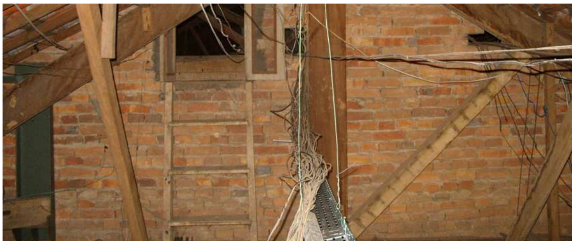
Figura 41: Parede de tijolos na sede fazenda Pau' Alho, visto acima do forro: aparelho flamengo
