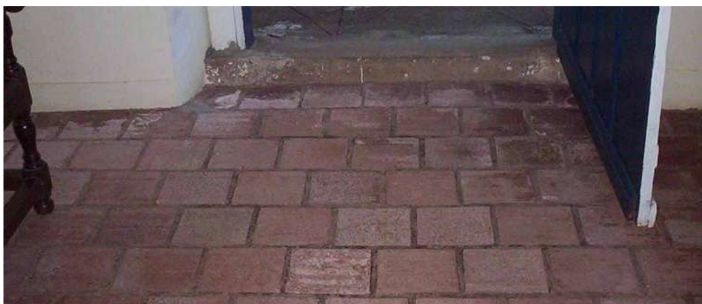
Figura 43: Lajotas de barro que foram mantidas na sede baixa da fazenda Pau d'Alho
