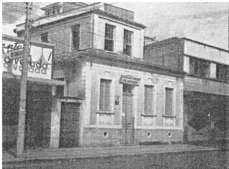
Figura 21: Residência com água furada na Av. Francisco Glicério
