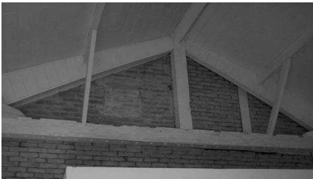
Figuras 32: Acima: edificação do depósito ao lado da sede aparentando o encamisamento de tijolo já sem a taipa de mão (observar os furos na face inferior da viga onde situavam os paus roliços da taipa de mão), detalhe (foto ao lado): beiral do depósito mantido mesmo com a reforma e ao fundo da foto, a platibanda da sede
