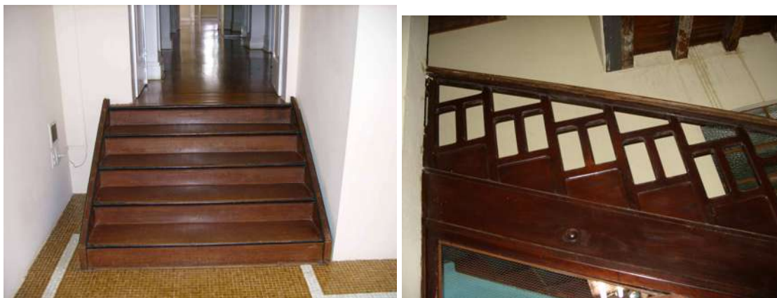
Figuras 78 e 79: Escada de madeira sem corrimão que liga corredor da sede alta ao salão da sede baixa da Pau d' Alho; à direita, escada de madeira do Chalet do Bosque dos Jequitibás, projetado por Ramos de Azevedo dois anos antes, apresentando corrimão de madeira
