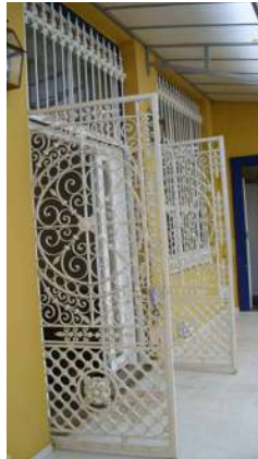
Figuras 93 e 94: Portas externas da sede baixa: porta na fachada frontal em verga reta e folha entaleirada da sede com ornamentos colocados por conta da reforma e porta na fachada posterior com gradil de ferro
