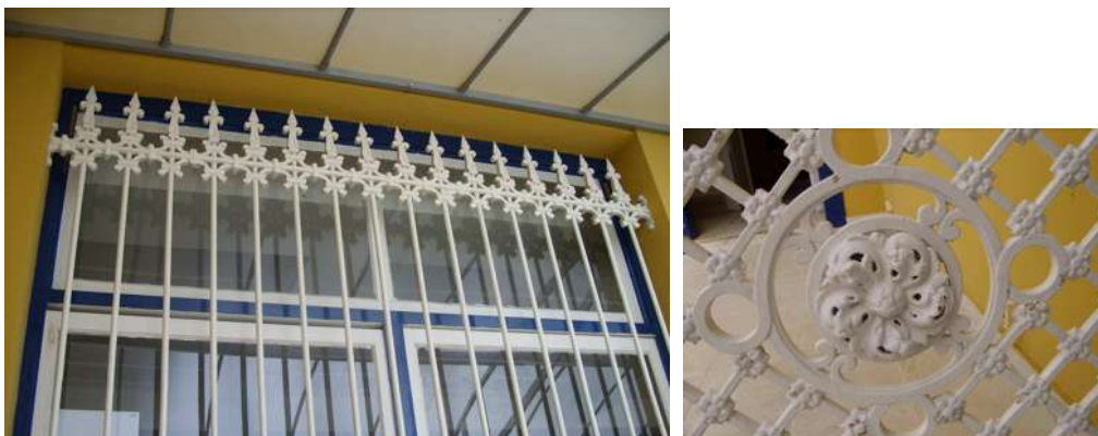
Figuras 142 e 143: Sede baixa – gradil da janela do salão com setas que se aproximam do formato do gradil da portinha de acesso ao alpendre; detalhe da folha de ferro fundido da porta do salão
