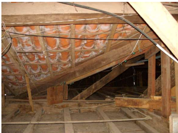
Figura 59: Tesoura de madeira na sede baixa da Pau d' Alho
