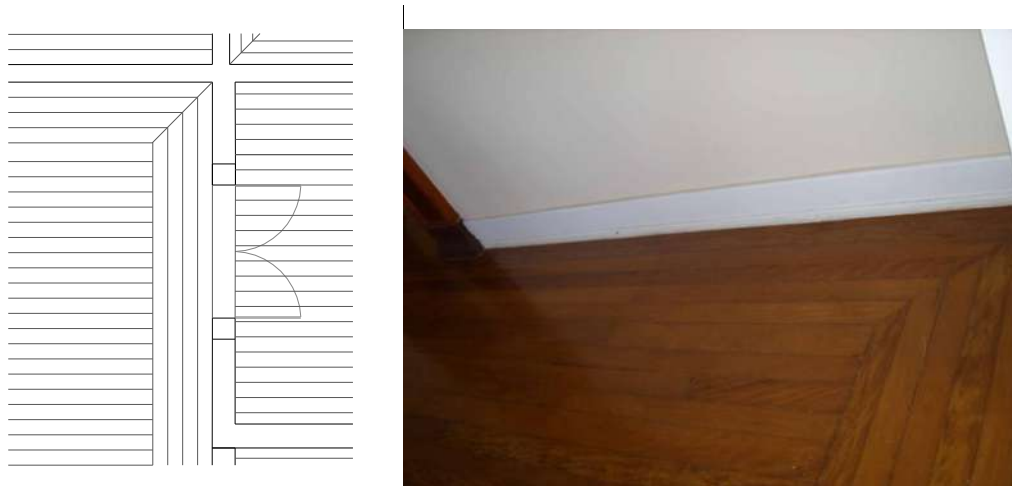
Figuras 126 e 127: Desenho da tabeira cercando piso da sala na sede alta da fazenda Pau d' Alho e sua foto
