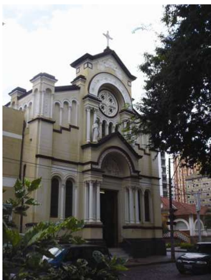
Figura 26: Fachada da Capela São Benedito
