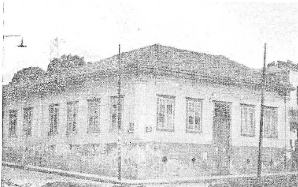
Figura 20: Casa de Sampaio Peixoto, demolida
