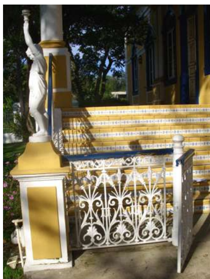
Figuras 75 e 76: Escada da fachada frontal da sede alta: acesso lateral do alpendre antes e depois da intervenção do Campinas Decor, em que o degrau ganhou revestimento de ladrilho. Notar, na primeira foto, a saliência dos degraus antes da intervenção 67
