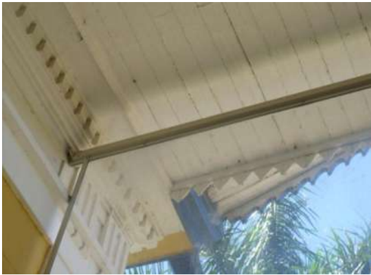
Figura 130: Forro tipo mecha-e-encaixe: na saleta, na varanda com cornija, e na saleta com motivos florais
