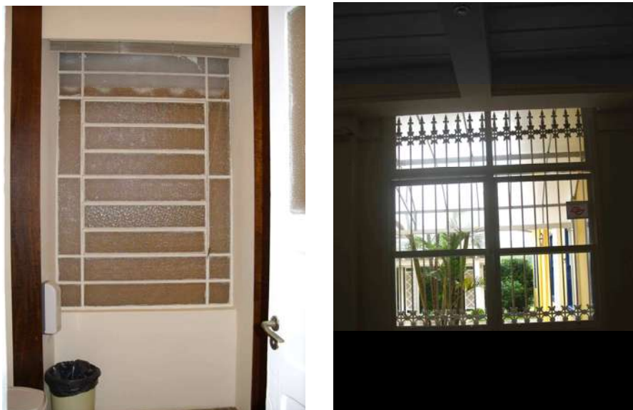
Figuras 99 e 100: Janela com caixilhos de ferro: da dispensa, na sede alta, e janela com gradil de ferro ornamentado, no salão da sede baixa
