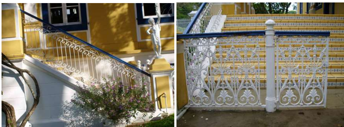
Figuras 140 e 141: Sede alta – gradil da escada lateral do alpendre ornamentado e porta de acesso à escada, de ferro fundido
