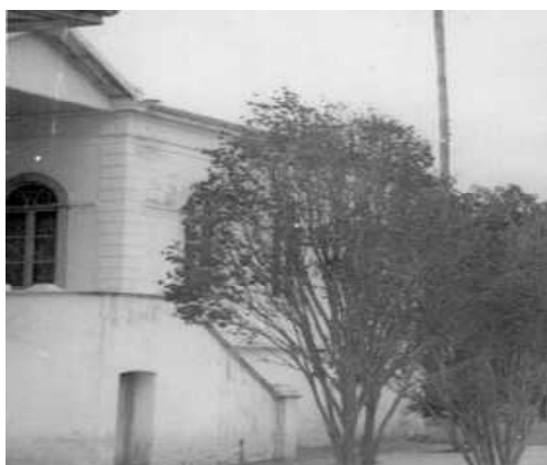
Figura 77: Escada da fachada posterior da sede alta: uma das raras imagens mostrando a escada original, demolida com a reforma de 1950, em que o porão teve pé-direito diminuído
