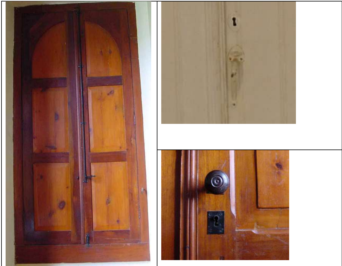
Figuras 147 e 148: Dobradiça e ferrolho das janelas da sede alta. À direita, detalhe das fechaduras; Acima, fechadura da porta mais antiga, situada na sede baixa; Abaixo, fechadura de maçaneta redonda, situada na sede alta, ainda antes da intervenção do Campinas Decor 116
