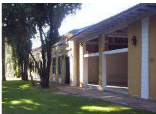
Figuras 32: Acima: edificação do depósito ao lado da sede aparentando o encamisamento de tijolo já sem a taipa de mão (observar os furos na face inferior da viga onde situavam os paus roliços da taipa de mão), detalhe (foto ao lado): beiral do depósito mantido mesmo com a reforma e ao fundo da foto, a platibanda da sede
