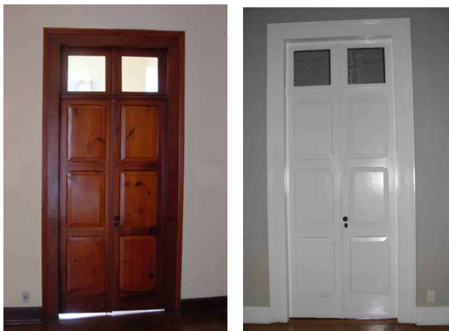
Figuras 87 a 90: Acima, portas da sede baixa: à esquerda, porta de travessa à cola e à direita, porta entaleirada com bandeira vedada de treliça; abaixo, porta da sede alta: à direita, porta envernizada antes da intervenção do Campinas Decor e o mesmo modelo de porta pintado de branco após intervenção
