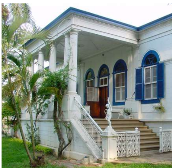
Figuras 75 e 76: Escada da fachada frontal da sede alta: acesso lateral do alpendre antes e depois da intervenção do Campinas Decor, em que o degrau ganhou revestimento de ladrilho. Notar, na primeira foto, a saliência dos degraus antes da intervenção 67
