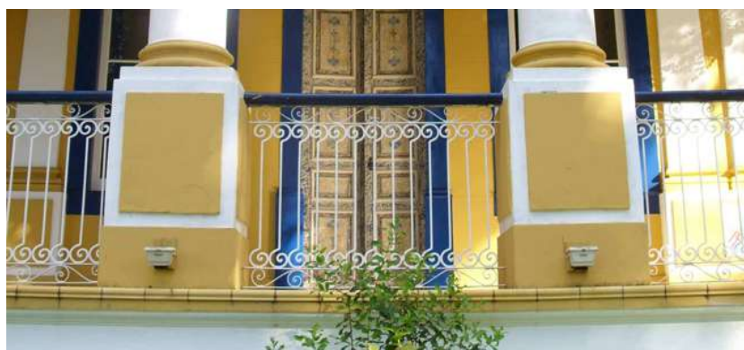
Figura 137: Corrimão de madeira com gradil de ferro no alpendre na sede alta
