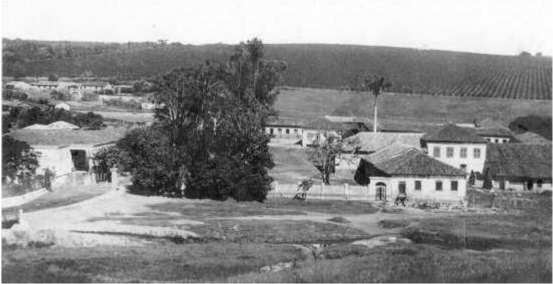
Figura 05: Casa de máquinas e tulha à direita, parcialmente preservados no início do século XX
