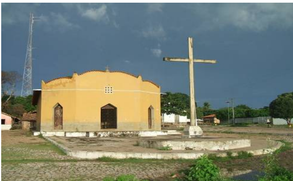
Figura 3 - Igrejinha de São Francisco, construída no local onde era a Igreja de Nossa Senhora da Conceição
