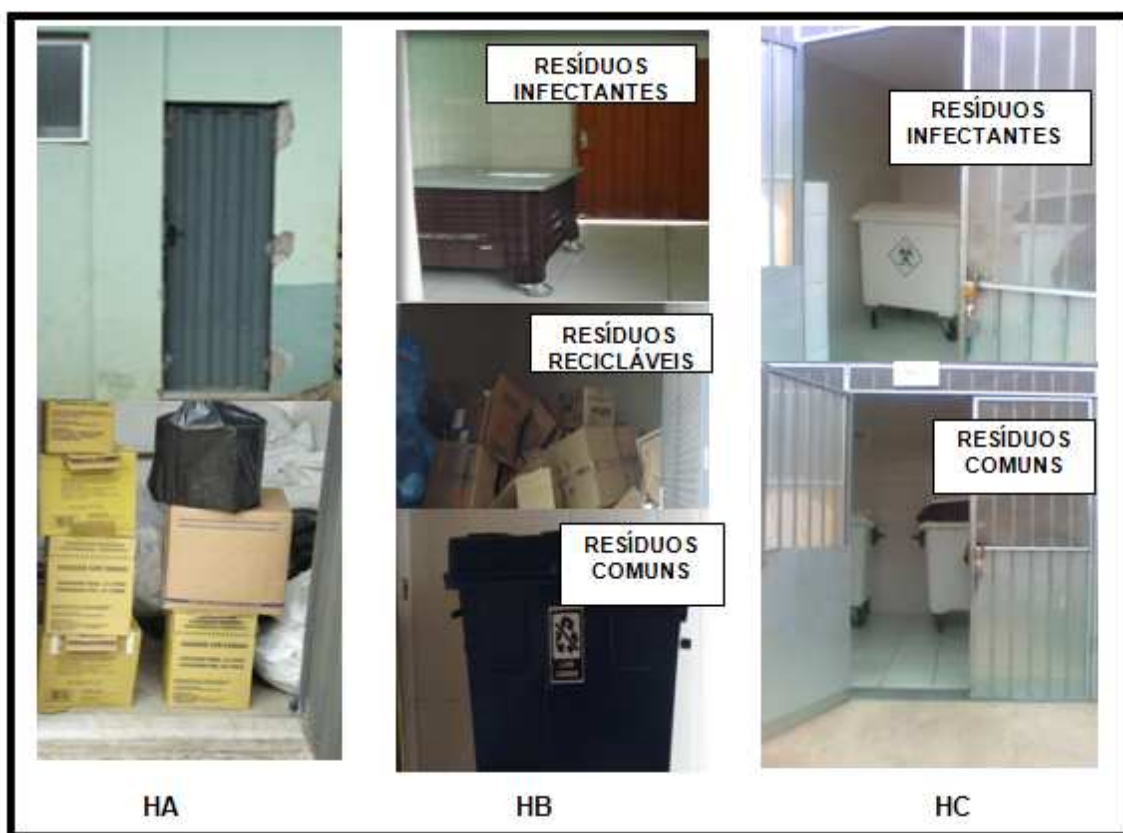
Figura 4.5a – Abrigos externos dos RSS dos hospitais A, B e C
