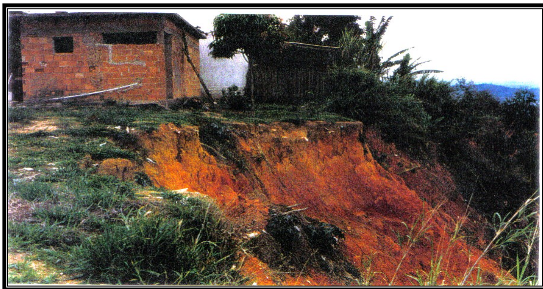
Figura 5.2.2.4: Construção de residência no interior da voçoroca Amado Batista Fonte: Sobreira, 1998
