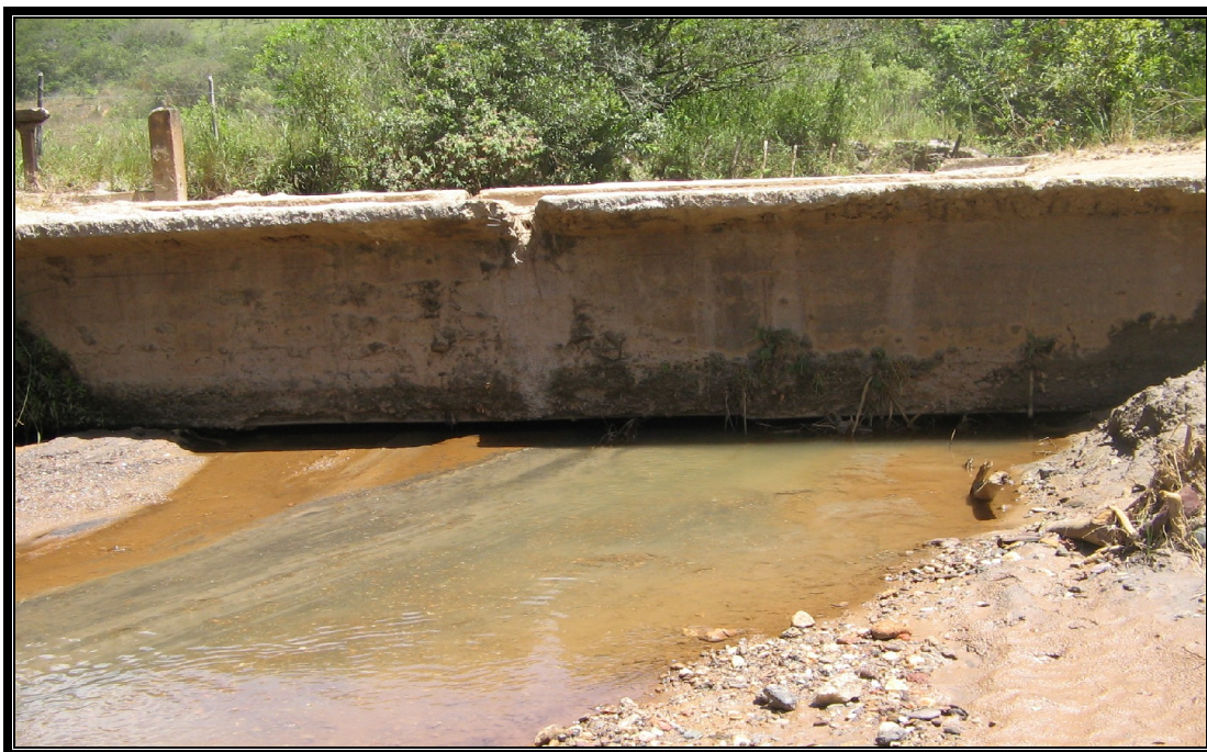
Figura 5.4.1: Ponte sobre o Córrego Cipó
