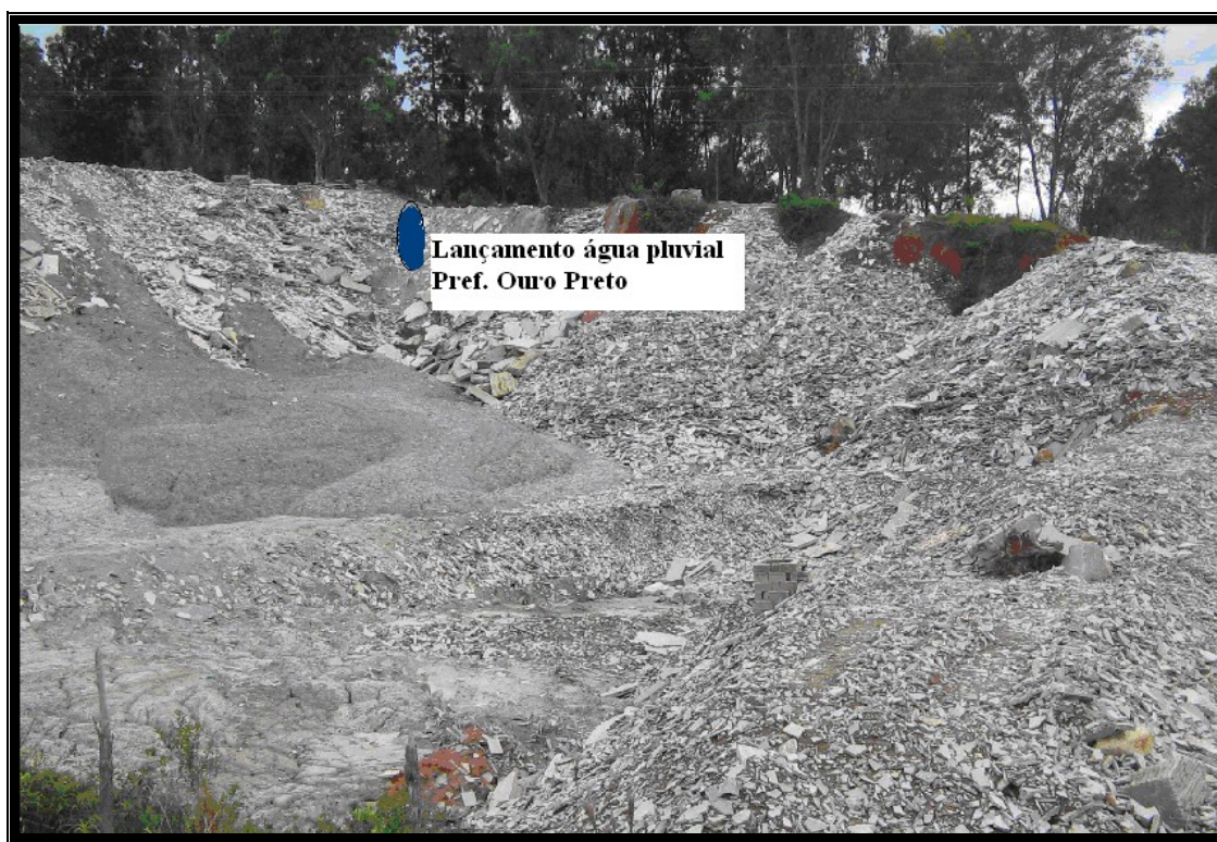
Figura 5.2.2.3.1: Recuperação voçoroca OPPS/ Lançamento água pluvial
