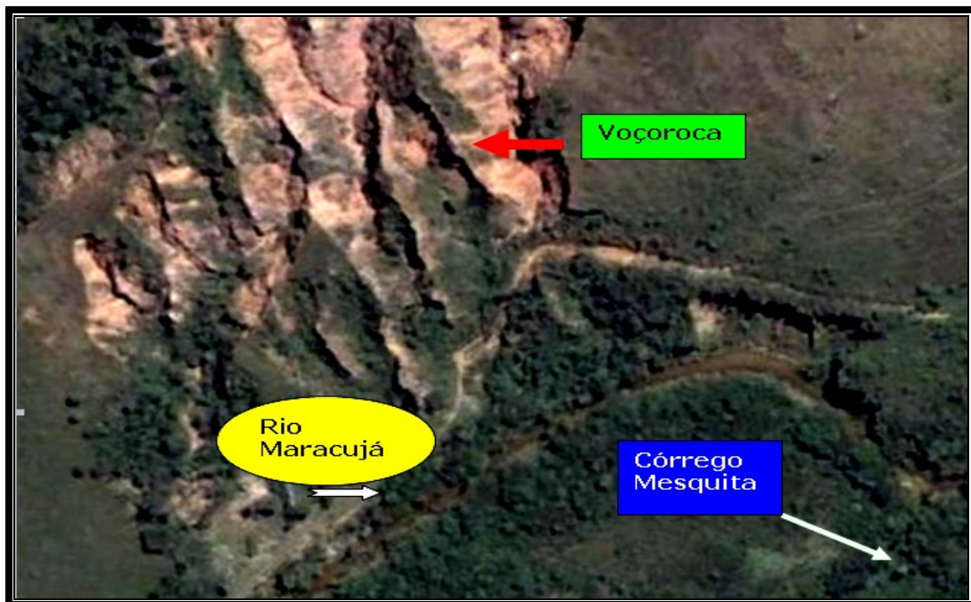
Figura 5.2.2.3: Voçoroca na foz do Rio Maracujá Fonte: Fonte: www.google earth.com
