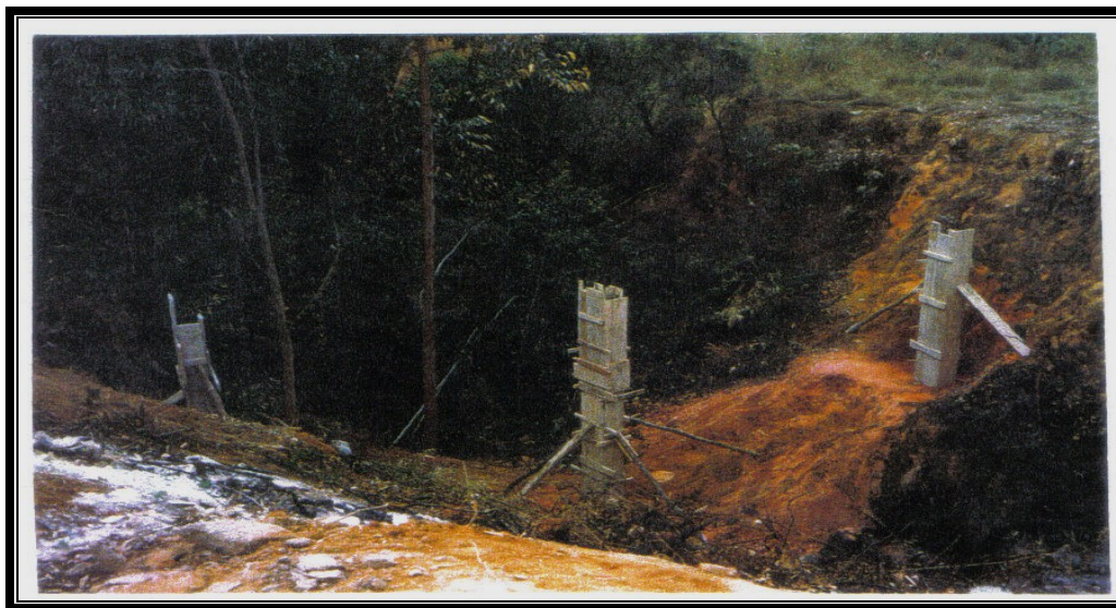
Figura 5.2.2.5: Construção de residência no interior da voçoroca Amado Batista Fonte: Sobreira, 1998
