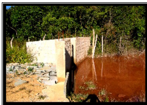
Fig. 5.2.17: Vertedouro dique 2 OPPS
