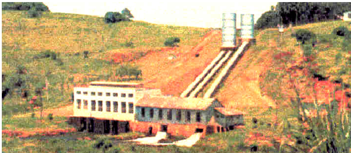
FIGURA 2.8 – Chaminés de Equilíbrio da PCH Caveiras (ELETROBRÁS, 2000).
