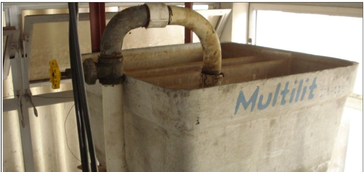
FIGURA 4.2 – Reservatório de Montante.
