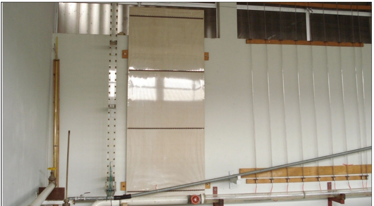
FIGURA 4.4 – Conduto de Adução e Chaminé de Equilíbrio.
