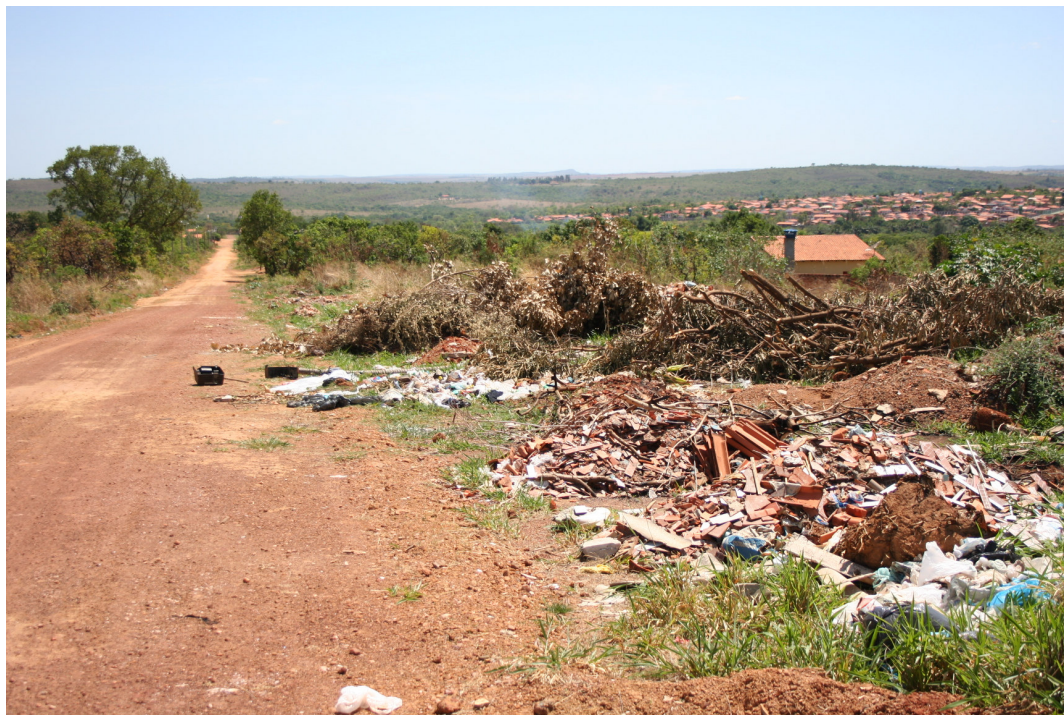
Figura 24 - Deposição de entulhos de construção e resíduos sólidos domiciliares próximo à residências no setor Mansões das Águas Quentes.
