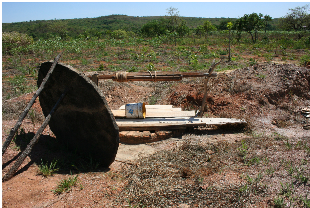
Figura 32 - Detalhe do poço raso utilizado para abastecimento de água em residência no Setor Mansões das Águas Quentes.
