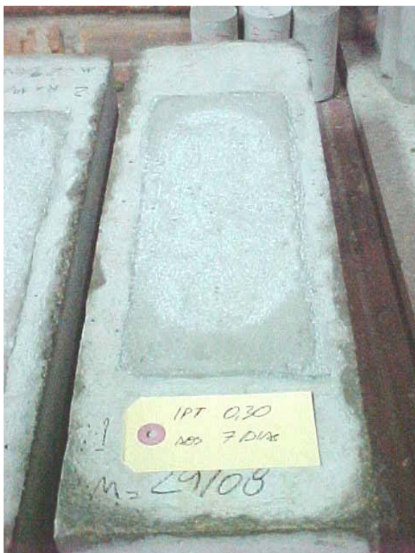
Fotografia 6.10 – Avaliação do aparecimento de fissuras
