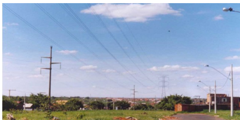
Figura 9 - Residência construída no início da área reservada à Cemig-Mg/2004
