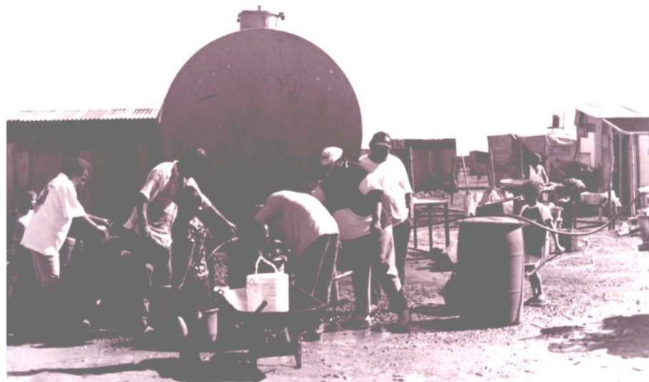
Figura 24 - Tanque água do Dmae no loteamento São Francisco/Joana D'Arc/2001
