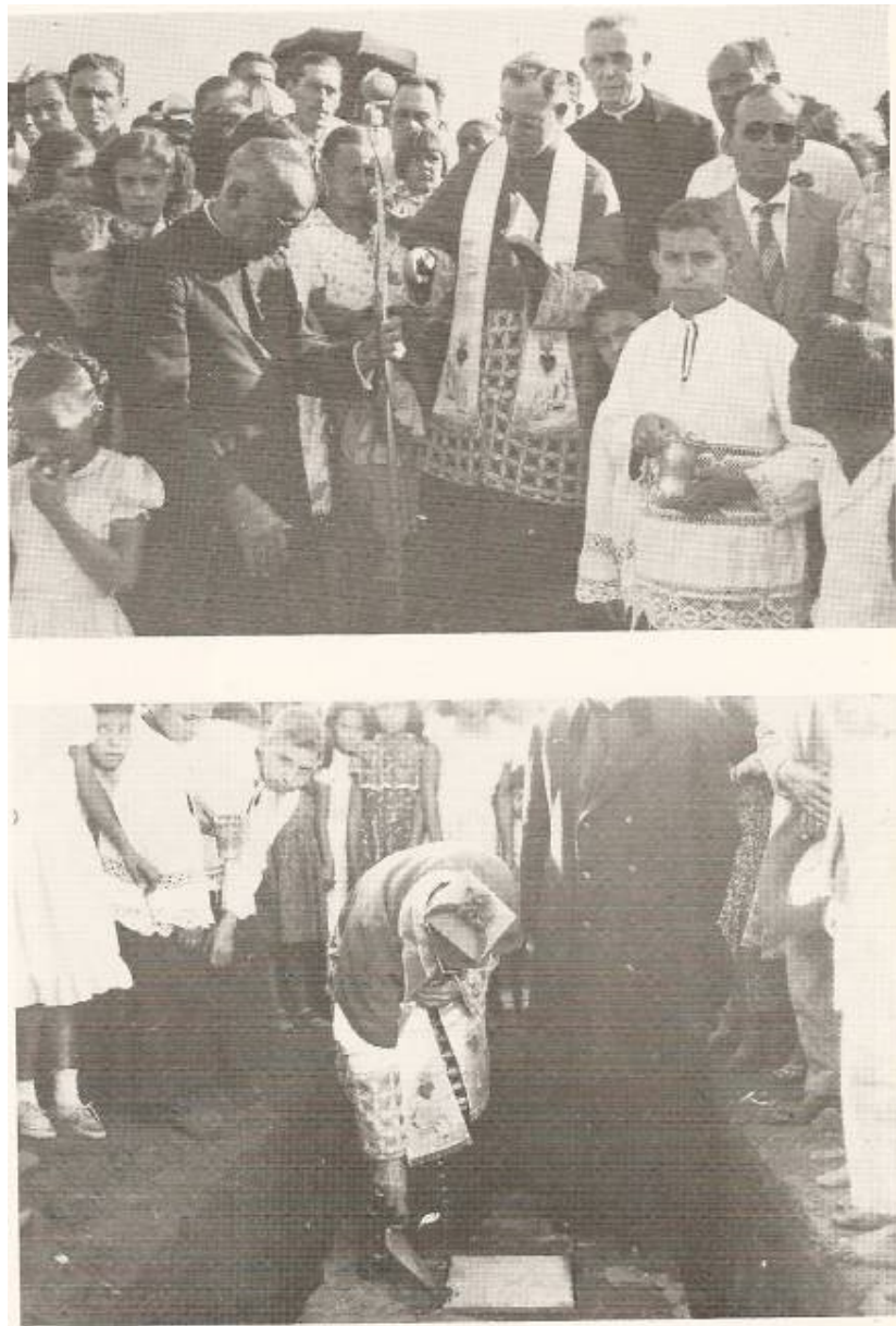
Figura 7 - Em 1952 Dom Alexandre benze e assenta a primeira pedra do prédio do Ginásio Cristo Rei, que se tornaria o primeiro edifício do Campus Santa Mônica, UFU, o Mineirão Fonte: CUNHA, 1989, p.201.
