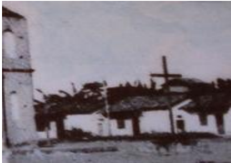
Fotografia 01 - Casas do conjunto popular construído na Vila Operária.
