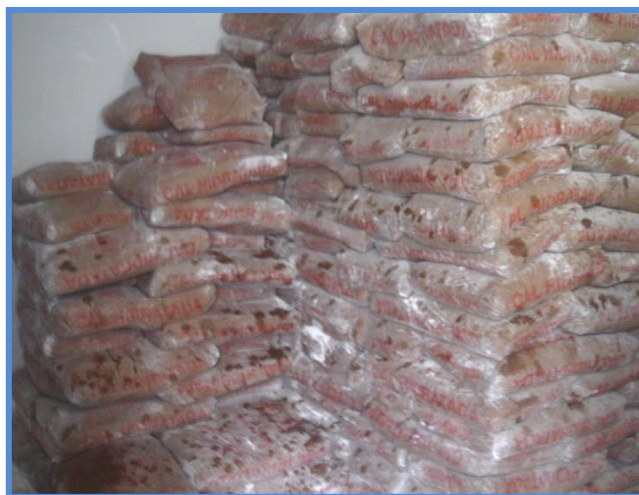
Figura 38 – Armazenamento inadequado de cal na ETA 2 do SiTA A.
