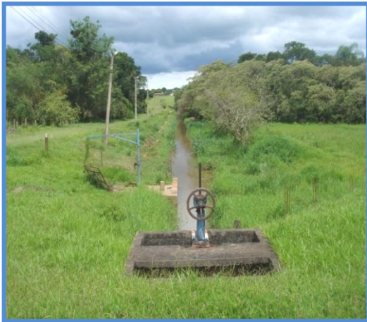
Figura 26 – Captação 2 do SiTA E.
