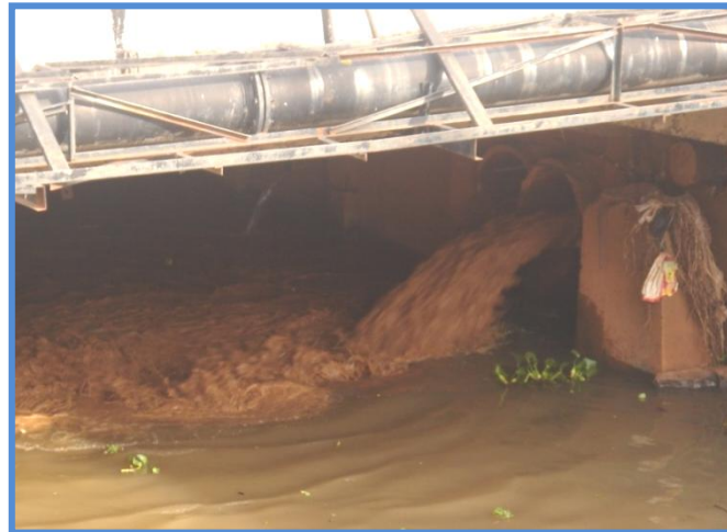
Figura 51 – Lançamento dos resíduos provenientes da limpeza dos decantadores a jusante do manancial de captação do SiTA G.
