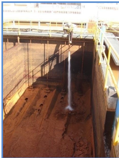
Figura 75 – Limpeza dos decantadores no SiTA G.
