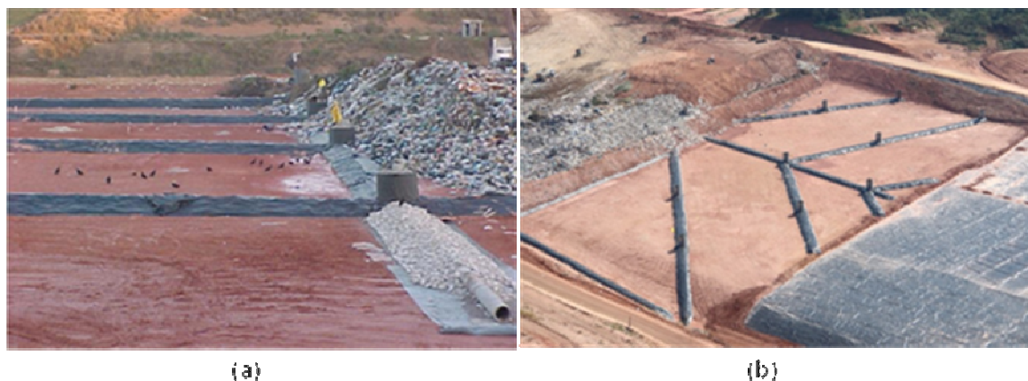
FIGURA 3.4 – REDE DE DRENAGEM DE LIXIVIADO SOBRE IMPERMEABILIZAÇÃO DE FUNDO, (a) FASE III, ETAPA 2.2; (b) FASE III, ETAPA 3
