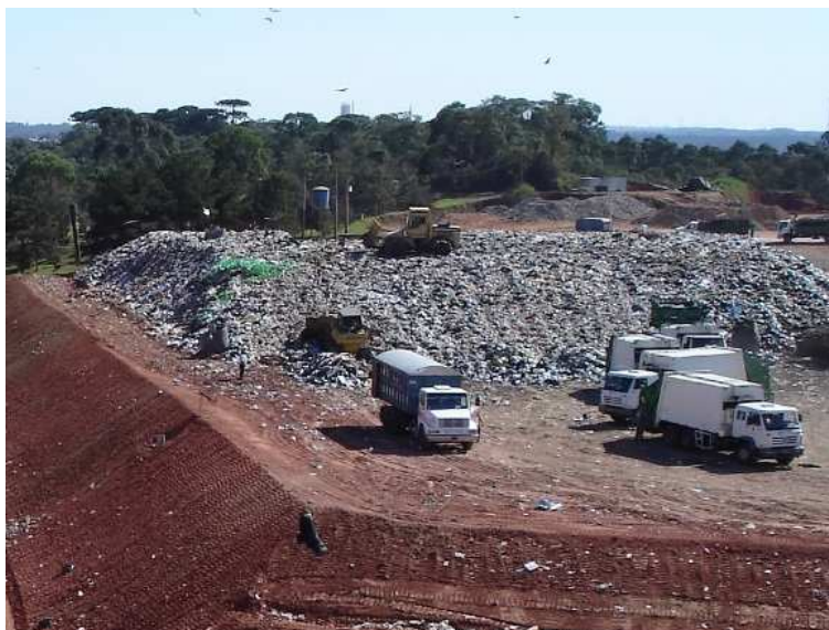
FIGURA 3.2 – DESCARGA, ESPALHAMENTO E COMPACTAÇÃO DOS RESÍDUOS
