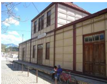
Estação de trem desativada na cidade de Bananal no Vale do Paraíba – SP – construída pelo sistema Damly de origem Belga, criado para ser exportado para países quentes que consiste em chapas duplas de ferro galvanizado com orifícios na parte inferior e superior, criando uma corrente de ar para refrigerar o sanduiche e sua montagem não necessitava de mão-de-obra especializada e era de rápida construção
