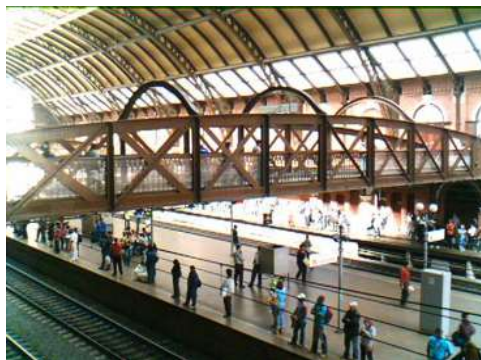
Estação da Luz - São Paulo - SP ferro fundido nos pilares e laminado nas vigas
