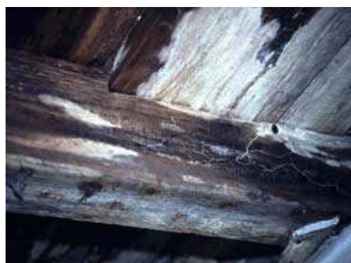
Peças de piso em madeira atacadas por fungos emboloradores e manchadores
