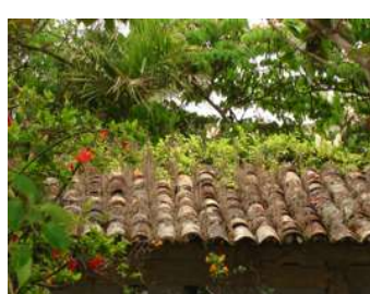
Telhas tipo capa e canal, de maior utilização em todo o país, devido ao seu baixo custo de fabricação em relação a telha francesa, sua forma era muito mais fácil de executar e sua produção muito mais simples
