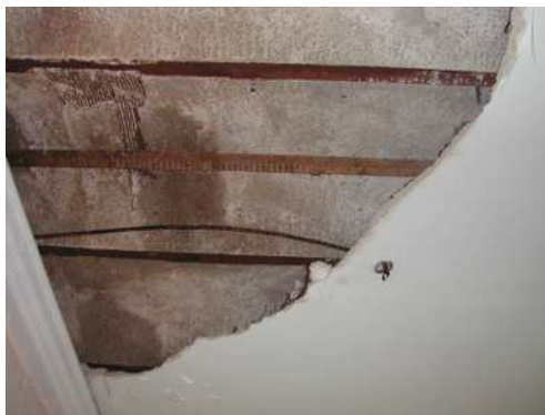
Forro de parte do 3º andar, debaixo da caixa d'água estruturado com tela deployée e perfis metálicos Museu Nacional – Rio de Janeiro – RJ
