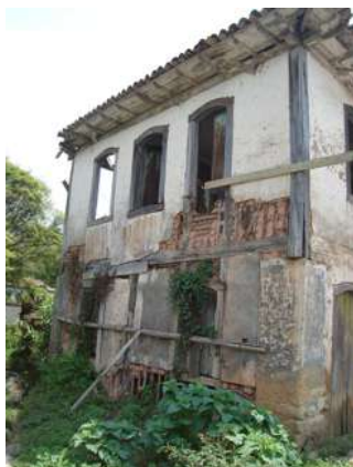
Estrutura do 2º andar de madeira
