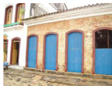
Casa em obras em Parati – RJ - tijolo assentado com argamassa de cal de marisco
