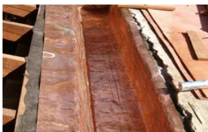
Calha nova em cobre, sem emenda, respaldada por calha de concreto armado impermeabilizada com manta à quente
