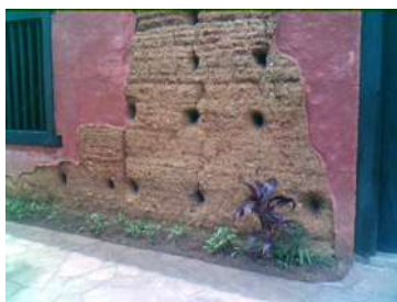
Capela do Morumbi, restaurada em 2003 jardineira junto a parede de taipa de pilão São Paulo – SP
