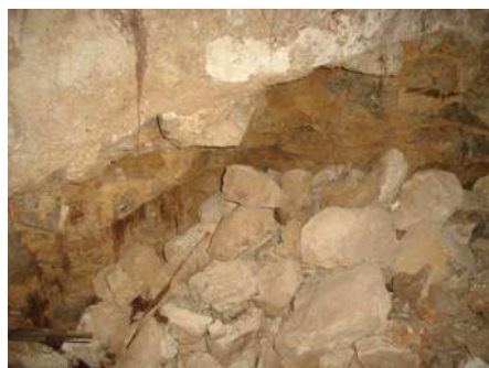
Alicerces de pedras grandes irregulares, calçadas por pedras menores, preenchidas com calda de barro, estruturando paredes também de pedra de túnel recém aberto que ligava as cozinhas a sede do Paço de São Cristóvão – Museu Nacional – Rio de Janeiro – RJ
