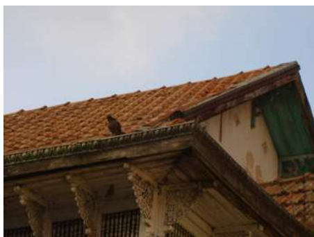
Ninho de pombo na calha e abaixo da platibanda antiga biblioteca de Teresópolis – Rio de Janeiro - RJ
