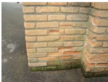
Igreja N.S. Aparecida – Aparecida – SP tijolo assentado com argamassa de cimento
