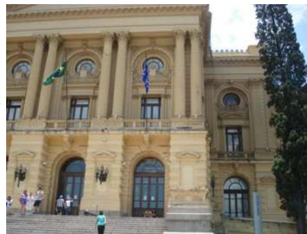
Tela de proteção na fachada do Museu Paulista São Paulo - SP
