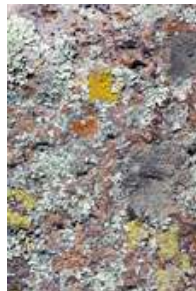
Ataque de líquenes em muro interno do Museu Imperial de Petrópolis - RJ
