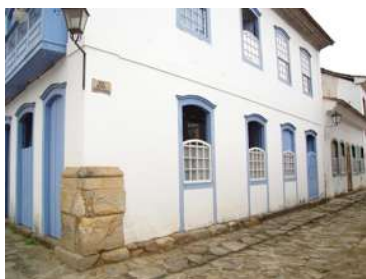
Alicerces ensoleirados – Parati – RJ
