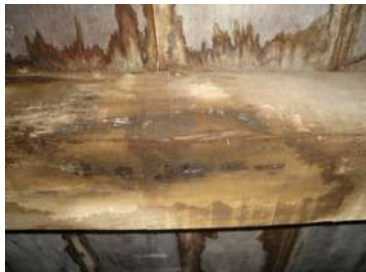
Início de ataque de fungos emboloradores e manchadores em madeira recém substituída no Forte dos Reis Magos – Natal – RN
