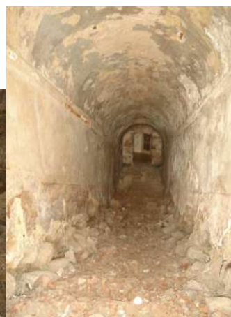
Alicerces de pedras grandes irregulares, calçadas por pedras menores, preenchidas com calda de barro, estruturando paredes também de pedra de túnel recém aberto que ligava as cozinhas a sede do Paço de São Cristóvão – Museu Nacional – Rio de Janeiro – RJ
