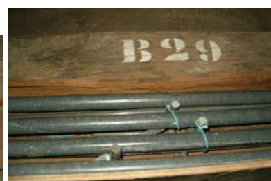
Reforço estrutural de tubo pultrudado no local do ataque dos fungos
