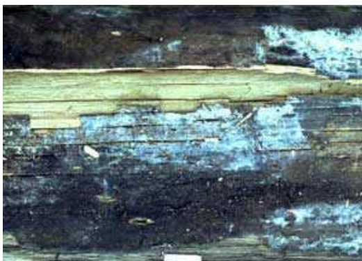
Peças de piso em madeira atacadas por fungos emboloradores e manchadores
