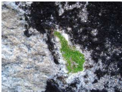
Muro da rua da catedral de São Pedro de Alcântara Petrópolis – RJ
