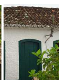
Telhas tipo capa e canal, de maior utilização em todo o país, devido ao seu baixo custo de fabricação em relação a telha francesa, sua forma era muito mais fácil de executar e sua produção muito mais simples
