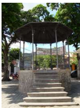
Coreto em cobertura metálica de chapa de zinco, pintado de cor acinzentada - Praça Quintino Bocayuva Quintino – Rio de Janeiro – RJ
