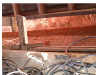
Calha nova em cobre, sem emenda, respaldada por calha de concreto armado impermeabilizada com manta à quente
