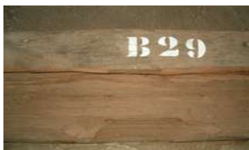
Retirada de ataque de fungo em grande parte de uma peça de telhado
