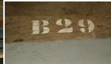
Consolidação do local atacado com resina epoxi
