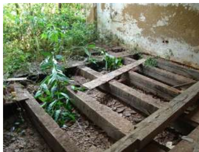
Estrutura do piso do 1º andar em madeira
