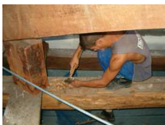
Retirada de ninho de cupim de madeira seca em peça de telhado
