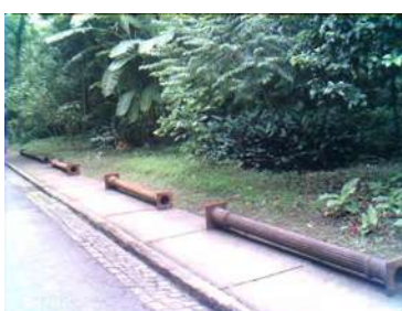
Pilares em ferro fundido substituídos no Museu Nacional nas obras de 1945
