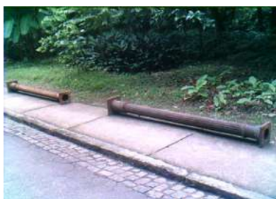
Pilares em ferro fundido substituídos no Museu Nacional nas obras de 1945
