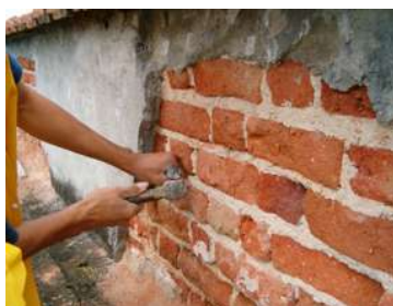
Recuperação de alvenaria de tijolos de vários tamanhos – Museu Nacional - Rio de Janeiro – RJ
