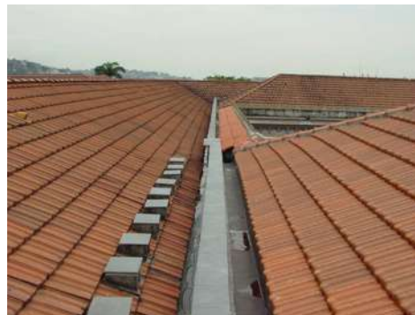
Calhas do Museu Nacional antes e depois da intervenção, aumentando a capacidade da calha por causa do aumento do índice pluviométrico da região nas últimas décadas – Museu Nacional – Rio de Janeiro - RJ
