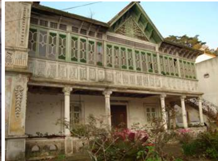
Ataque de fungos, cupim de madeira seca, pombos e morcego na antiga biblioteca de Teresópolis - RJ
