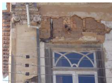
Casa na Praça da Matriz – Bananal - SP tijolo maciço e adobe com argamassa de cal
