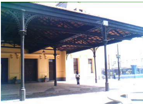
Estação terminal de trem do Valongo - Santos - SP ferro fundido nos pilares e laminado nas vigas
