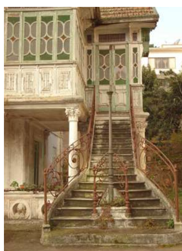
Corrimão e poste de iluminação no prédio da antiga biblioteca de Teresópolis – RJ ferro fundido
