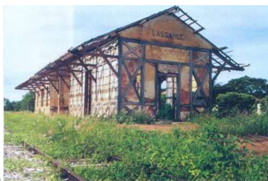
Estação ferroviária da cidade de Lassance antes da restauração em 2007, mostra bem a estrutura mista – Lassance – MG
