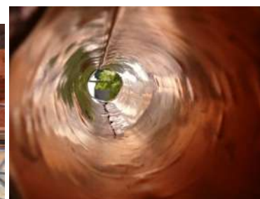
Buzinote novo construído com emenda de mão-de-amigo e soldado
