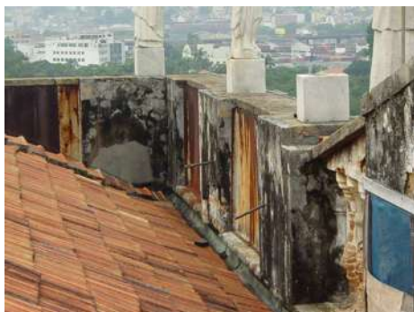
Calhas do Museu Nacional antes e depois da intervenção, aumentando a capacidade da calha por causa do aumento do índice pluviométrico da região nas últimas décadas – Museu Nacional – Rio de Janeiro - RJ
