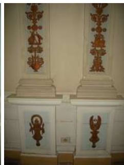
Antiga sala da direção do Museu Nacional, todos os adornos da alvenaria são em terracota fixados em madeira sobre a parede Quinta da Boa Vista – São Cristóvão - Rio de Janeiro – RJ
