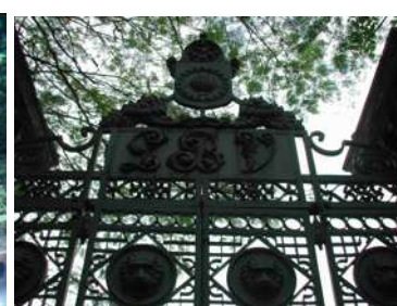
Portão externo do Horto Botânico do MN ferro fundido, laminado e estampado
