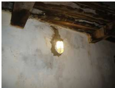
Início de ataque de fungos emboloradores e manchadores em madeira recém substituída no Forte dos Reis Magos – Natal – RN
