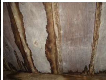
Início de ataque de fungos emboloradores e manchadores em madeira recém substituída no Forte dos Reis Magos – Natal – RN
