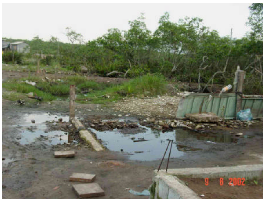
Figura 12: Vista de baldrame em primeiro plano e vegetação típica de mangue ao fundo na Favela Balneário Maxiland (Normélia C. Luz, 2002).
