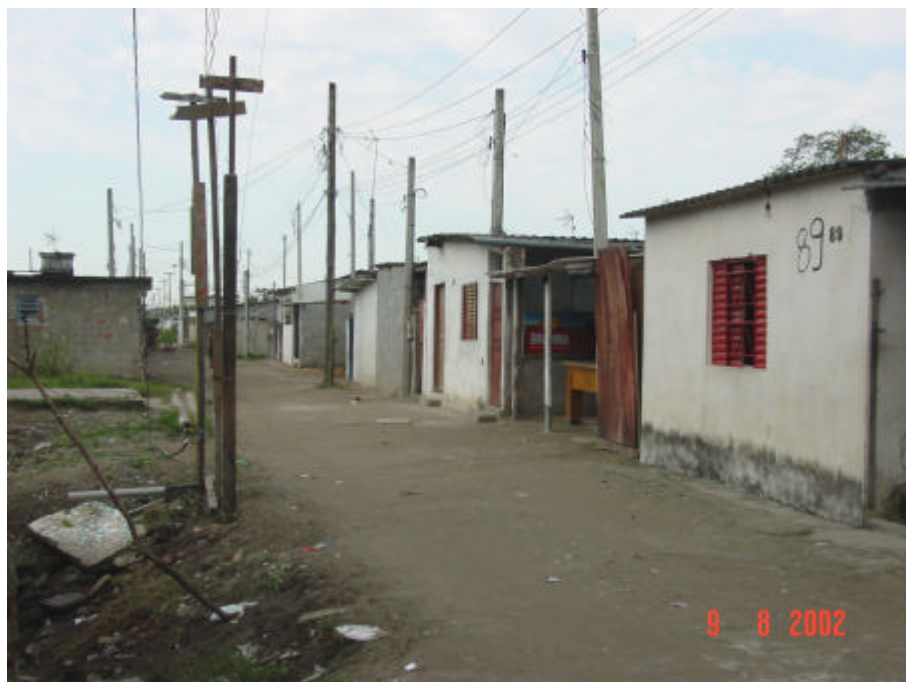
Figura 11: Outra vista da Favela Balneário Maxiland, observando-se a infra-estrutura adotada, com eletricidade e prolongamento da rede de água potável (Normélia C. Luz, 2002).
