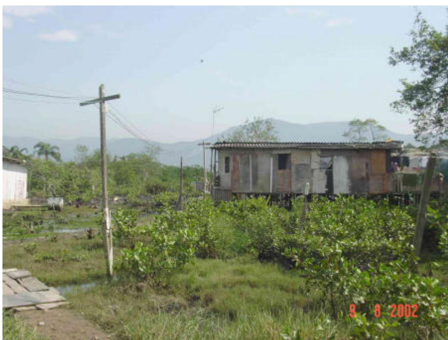
Figura 07: Detalhe de um dos barracos da Favela de Caieiras, vendo-se a invasão na área de mangue (Normélia C. Luz, 2002).
