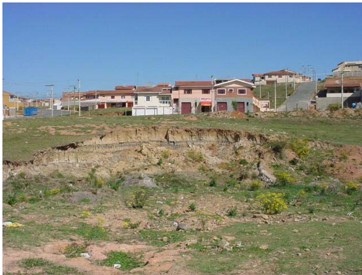
FIGURA 1: Processo erosivo na área urbana do Município de Poços de Caldas, provocado por alteração de leito de córrego no Loteamento Jd. Amarilys, coordenadas UTM 7.588.020N e 340.470E (MENDONÇA, 2002).
