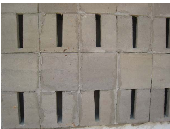
Figura 91. Foto da parede de teste montada com o bloco tipo 4 aberto sem lã de vidro (CG)
