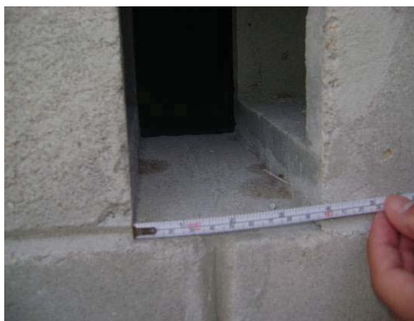
Figura 70. Foto do detalhe da separação de 10 cm da montagem mostrada na Figura 69
