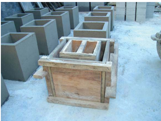
Figura 31. Foto da fôrma do elemento maior
