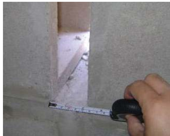
Figura 63. Foto do detalhe da separação de 5 cm da montagem mostrada na Figura 62
