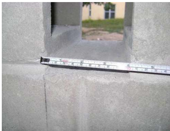
Figura 74. Foto do detalhe da separação de 10 cm da montagem mostrada na Figura 73
