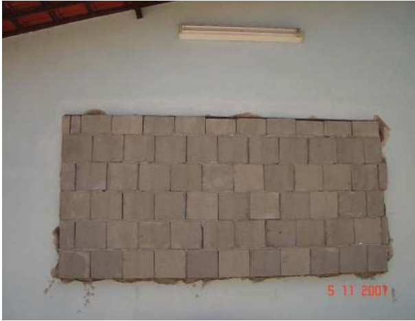
Figura 58. Tomada fotográfica da parede de testes montada, sem aberturas, com o bloco tipo 2_(Gfechado)
