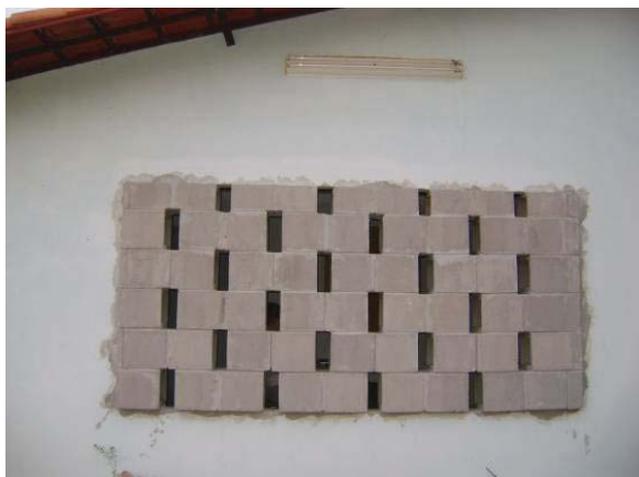
Figura 73. Foto da parede de teste montada com o bloco tipo espaçado 10 cm e sem lã de vidro ( G10s/lã )
