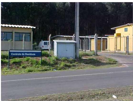
Figura 19: Vista da Unidade de Gestão de Resíduos (UGR).
