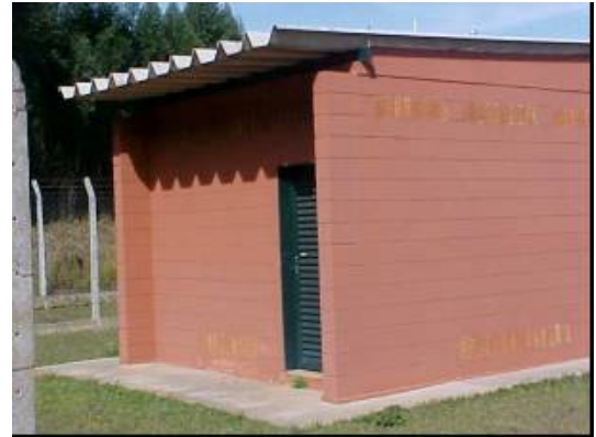
Figura 22: Estocagem de resíduos radioativos
