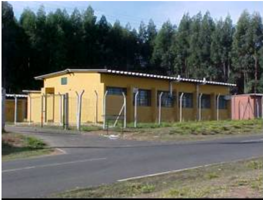
Figura 21: Laboratório de caracterização e processamento de resíduos
