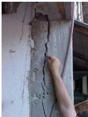
**Figura 4.7:** edificação com grave patologia estrutural. Observar a trinca no sentido longitudinal do pilar.
