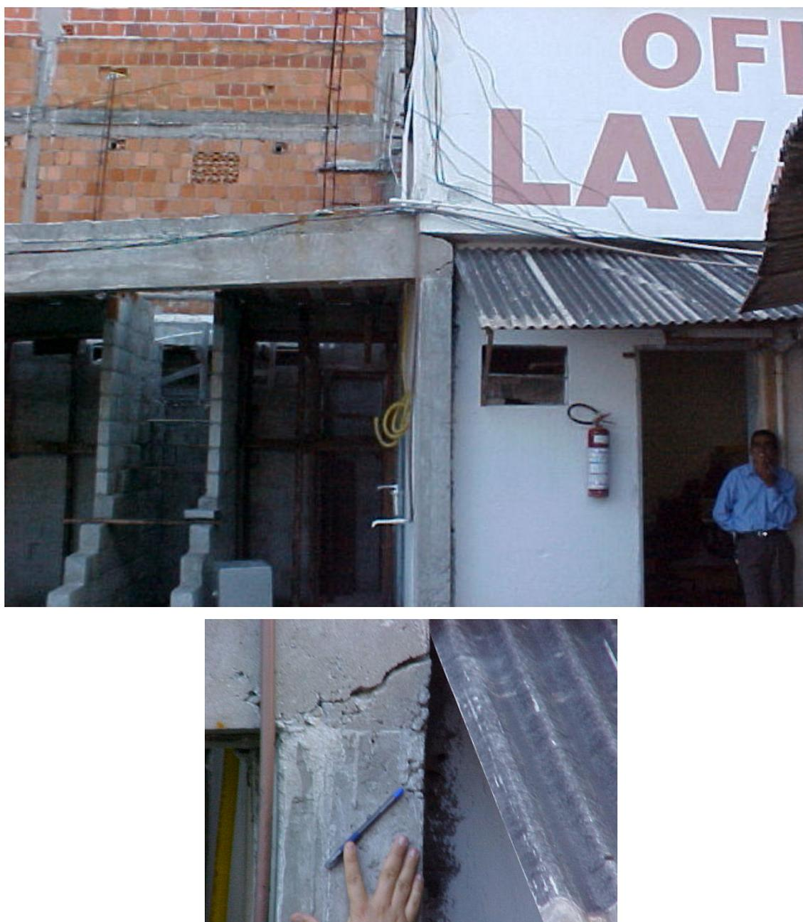
**Figura 4.6:** edificação com grave patologia estrutural. Observar no detalhe a trinca ocorrida pela deformação excessiva da viga.
