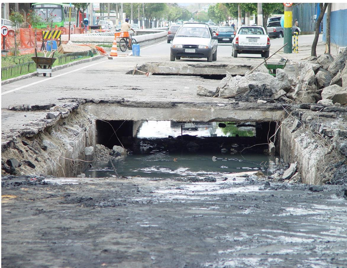
**Figura 4.11:** fotografia de uma galeria deteriorada pela ação agressiva de esgoto urbano, em Vitória - ES (TANCREDI, 2003).
