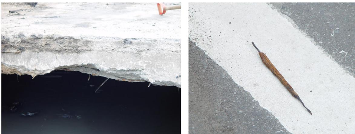
**Figura 4.12:** seção transversal da placa de concreto deteriorada e detalhe de uma barra da armadura principal, em avançado estado de corrosão (TANCREDI, 2003).
